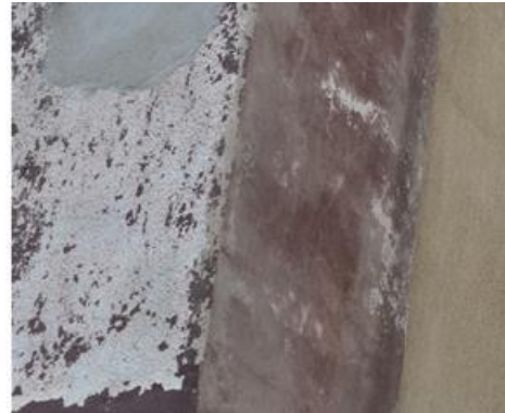
Fot.14. Bartoszyce, kamienica przy Placu Konstytucji 3 Maja 12- Odkrywka K, fot. B.Feiertag.
