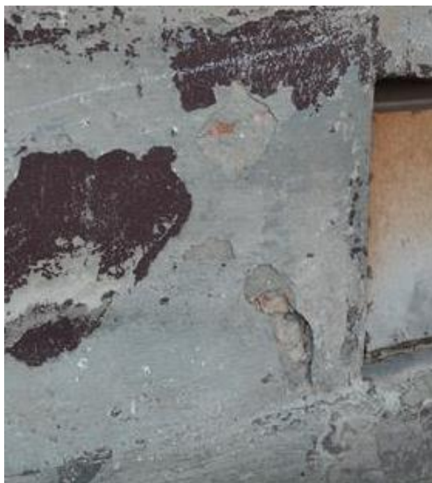
Fot.7. Bartoszyce, kamienica przy Placu Konstytucji 3 Maja 12- Odkrywka B, fot. B.Feiertag.
