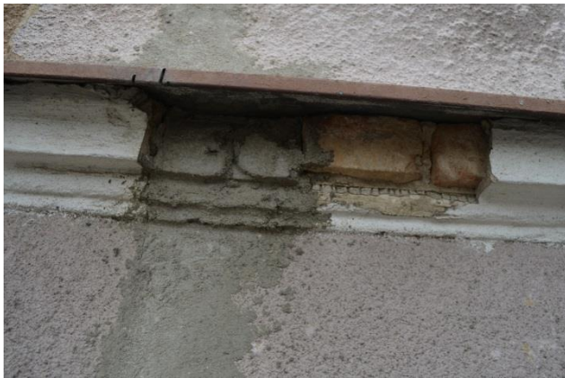
Fot.14. Bartoszyce, kamienica przy Placu Konstytucji 3 Maja 12- Odkrywka L, fot. B.Feiertag
