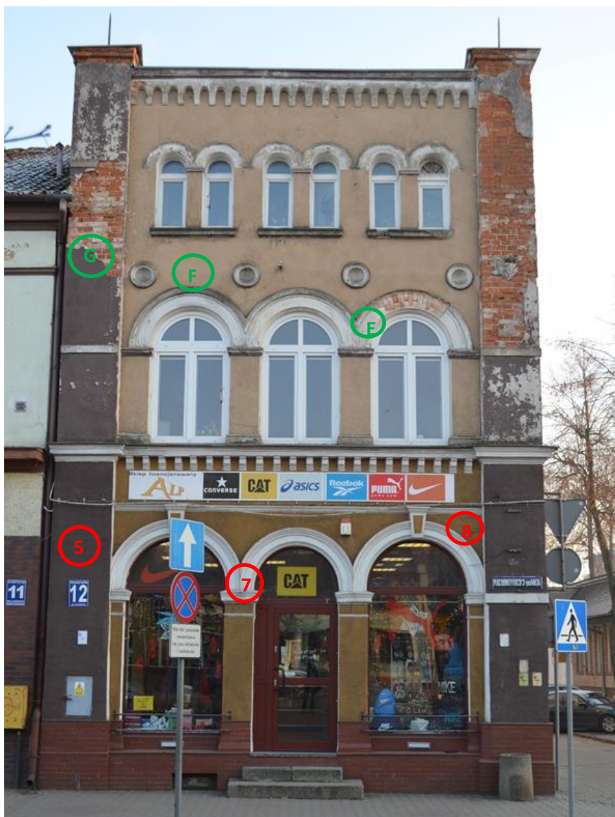
Fot.1. Bartoszyce, kamienica mieszkalna przy Placu Konstytucji 3 Maja 12- elewacja frontowa, miejsce pobrania próbek i wykonania odkrywek. Fot. B.Feiertag
