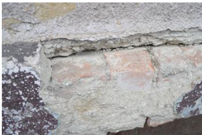
Fot.11. Bartoszyce, kamienica przy Placu Konstytucji 3 Maja 12- Odkrywka H, fot. B.Feiertag.
