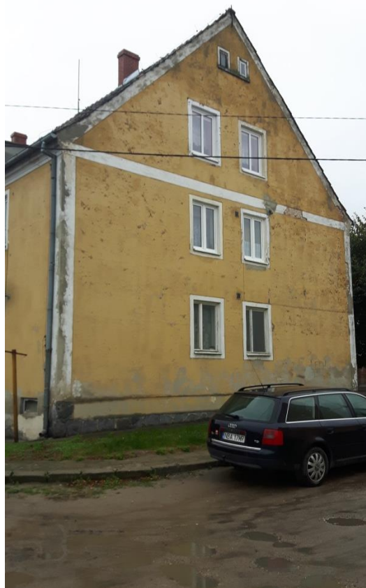
Fot.4. Bartoszyce – kamienica przy ul. Paderewskiego 15-17-19-21-23-25 – elewacja lewa.
