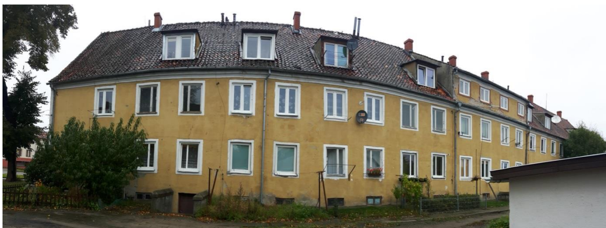
Fot.2. Bartoszyce – kamienica przy ul. Paderewskiego 15-17-19-21-23-25 – elewacja tylna.
