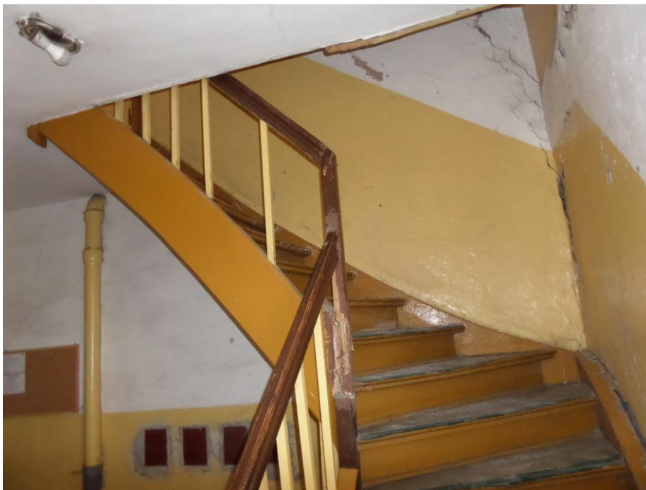
Zdjęcie nr 10. Klatka schodowa w budynku nr 1.
