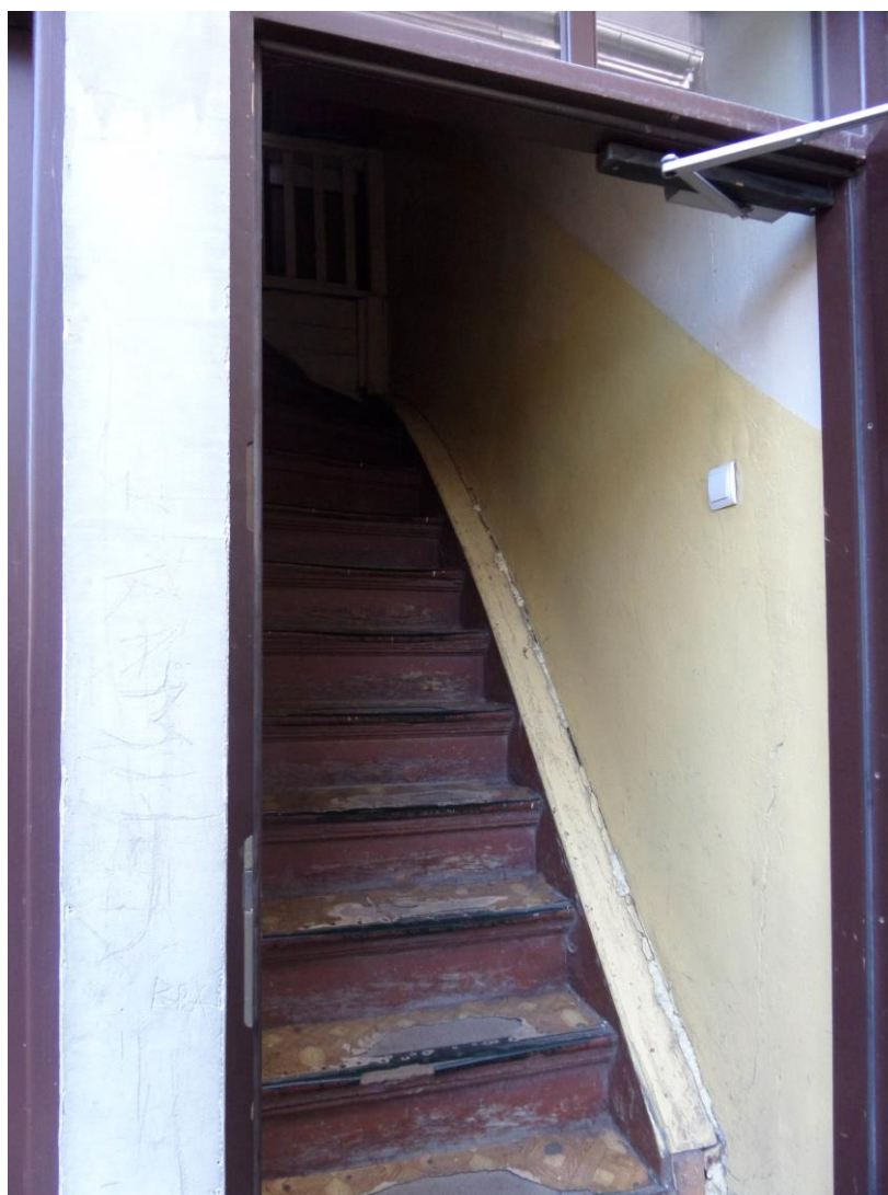
Zdjęcie nr 11. Klatka schodowa w budynku nr 2.
