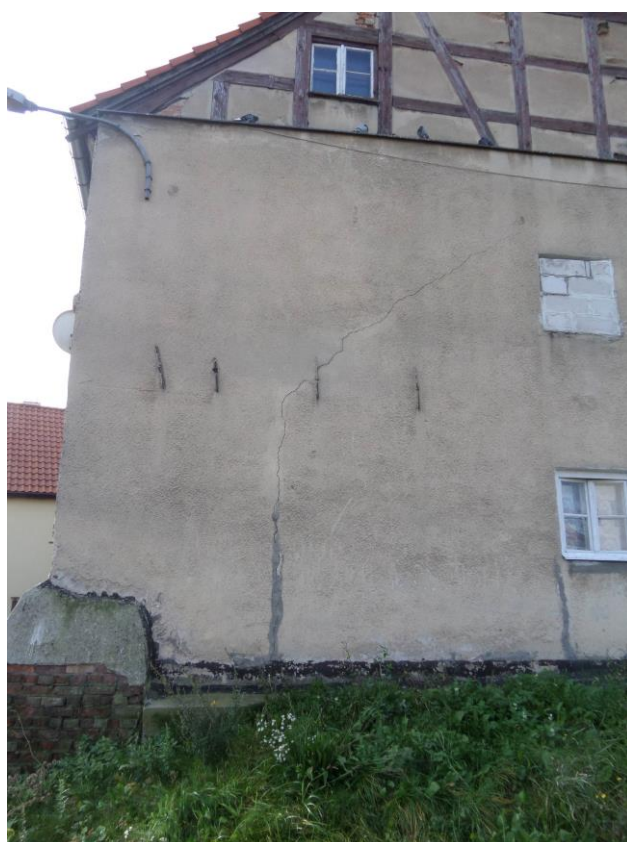
Zdjęcie nr 6. Przykładowe miejsce zastosowania systemu naprawy – ściana szczytowa budynku nr 2.
