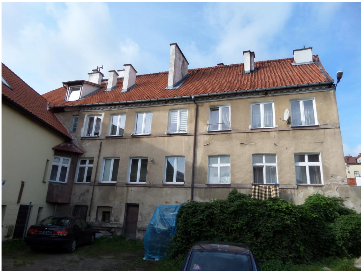
Zdjęcie nr 1. Elewacja wschodnia.
