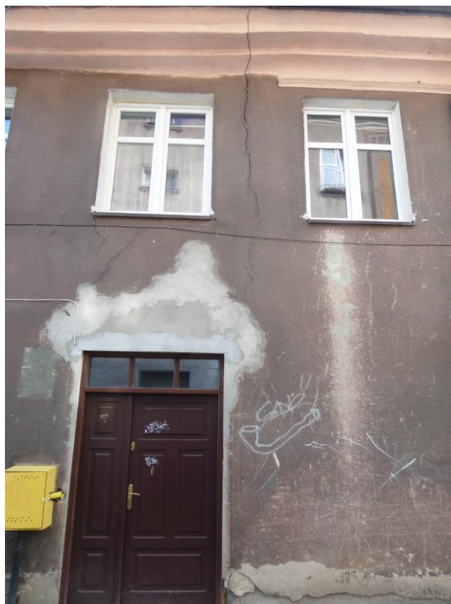
Zdjęcie nr 5. Przykładowe miejsce zastosowania systemu naprawy – klatka schodowa budynku nr 1.
