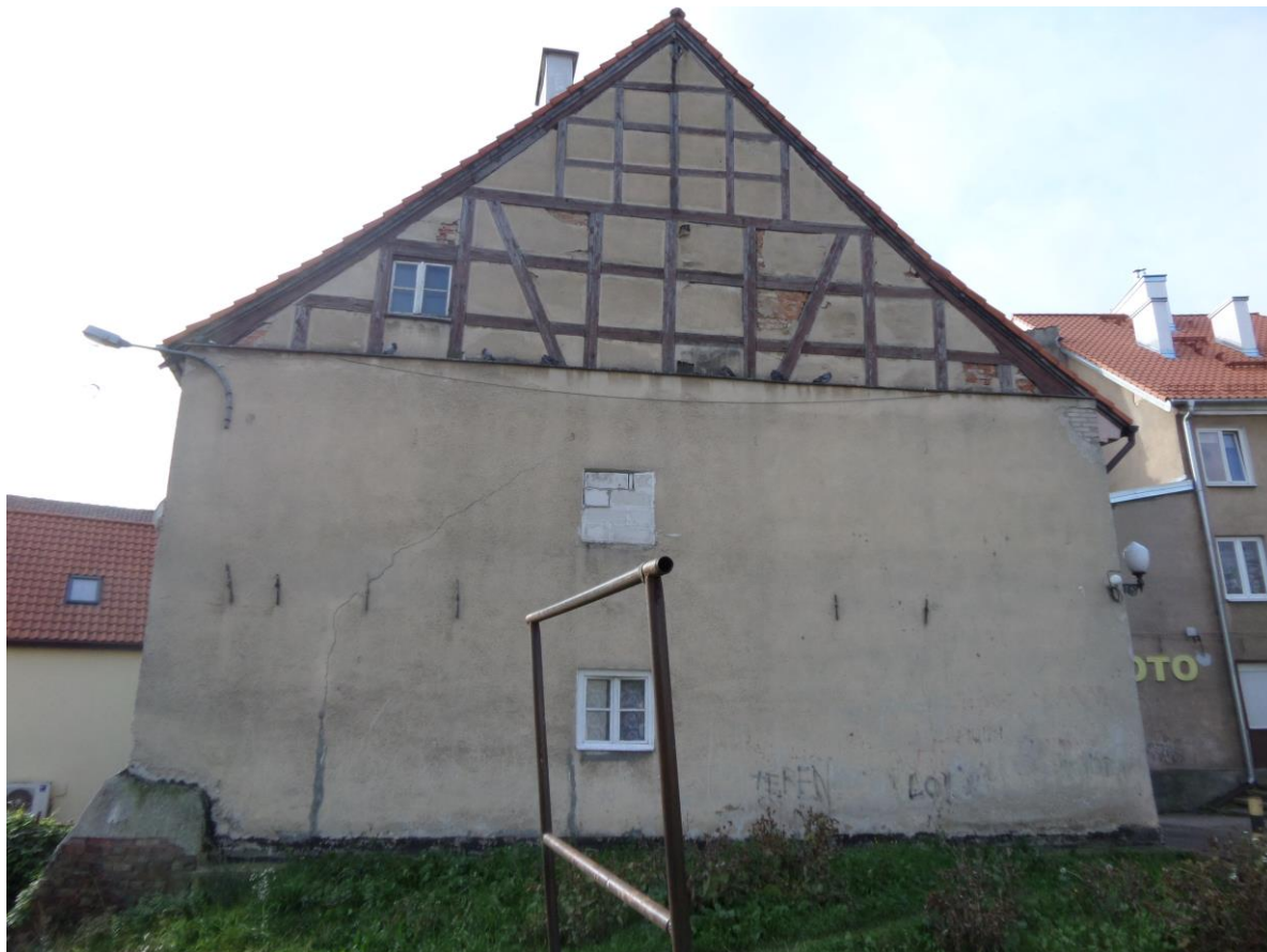
Zdjęcie nr 2. Elewacja północna.
