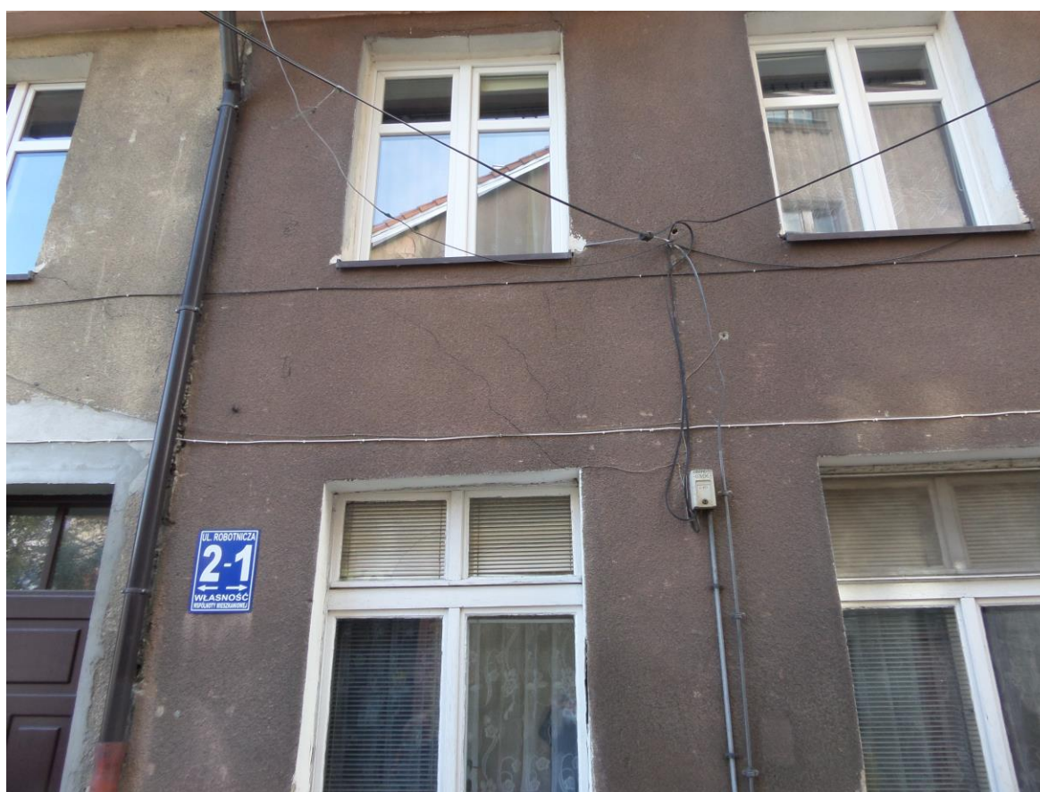
Zdjęcie nr 8. Przykładowe miejsce zastosowania systemu naprawy – nadproże nad oknem w budynku nr 1.
