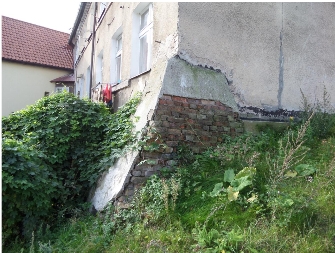
Zdjęcie nr 9. Przypora w północno-wschodnim narożniku budynku.
