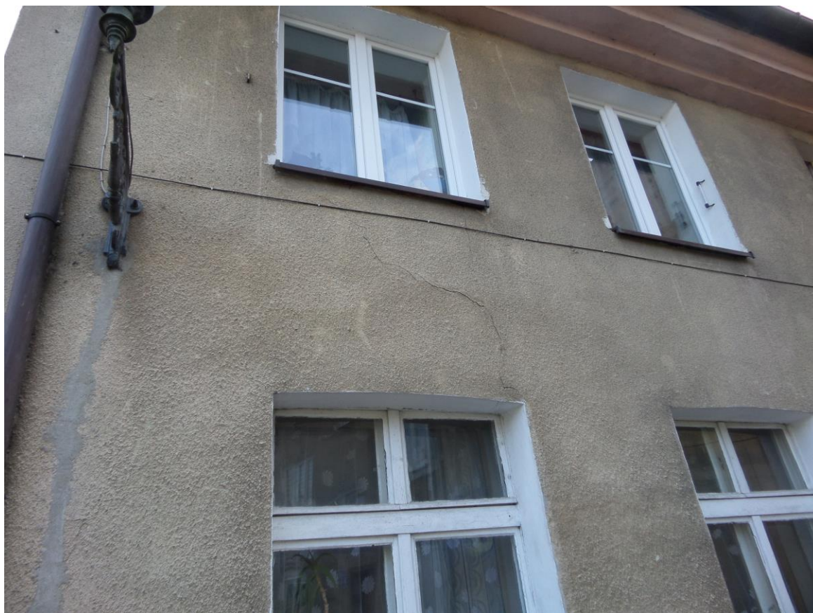
Zdjęcie nr 7. Przykładowe miejsce zastosowania systemu naprawy – nadproże nad oknem w budynku nr 2.
