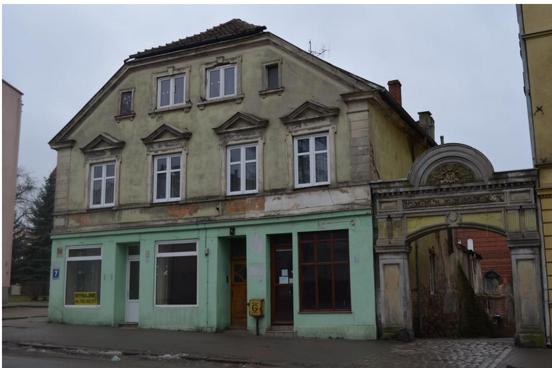
Fot.1. Bartoszyce, budynek mieszkalny ul. Bema 7 – elewacja frontowa, stan obecny. Fot. J.Baran.
