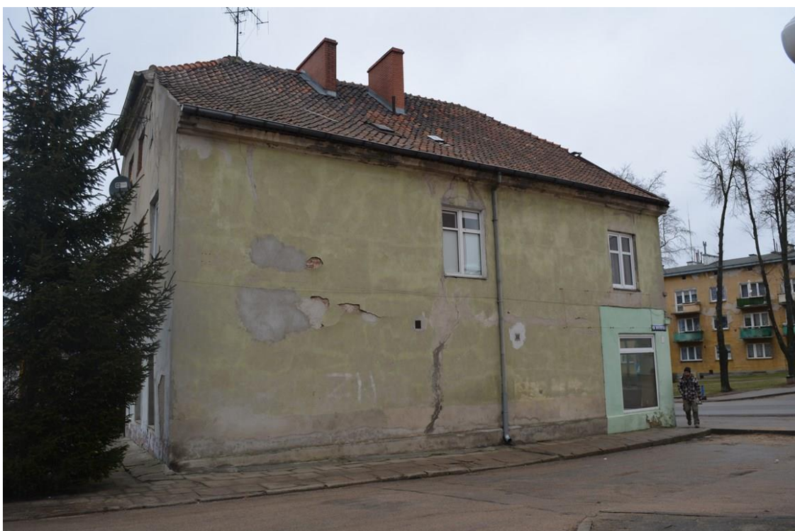
Fot.2. Bartoszyce, budynek mieszkalny ul. Bema 7 – elewacja boczna prawa, stan obecny. Fot. J.Baran.
