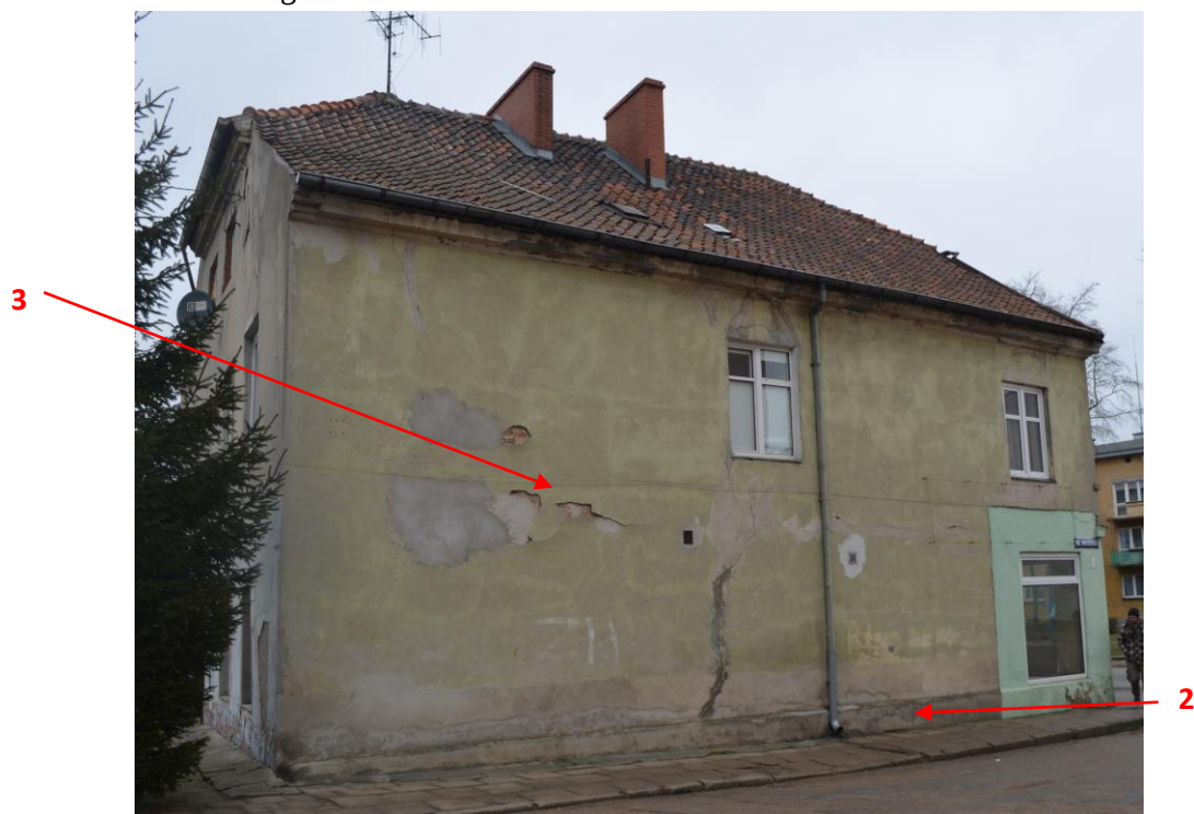
Fot.2. Bartoszyce- budynek mieszkalny przy ul. Bema 7- elewacja frontowa- miejsca pobrania próbek. Fot. M. Feiertag-Baran.
