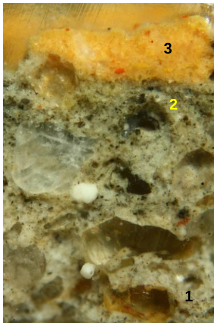
PRÓBKKA 5. Bartoszyce, kamienica przy ul. Bema 7, fryz nad witrynami sklepowymi
