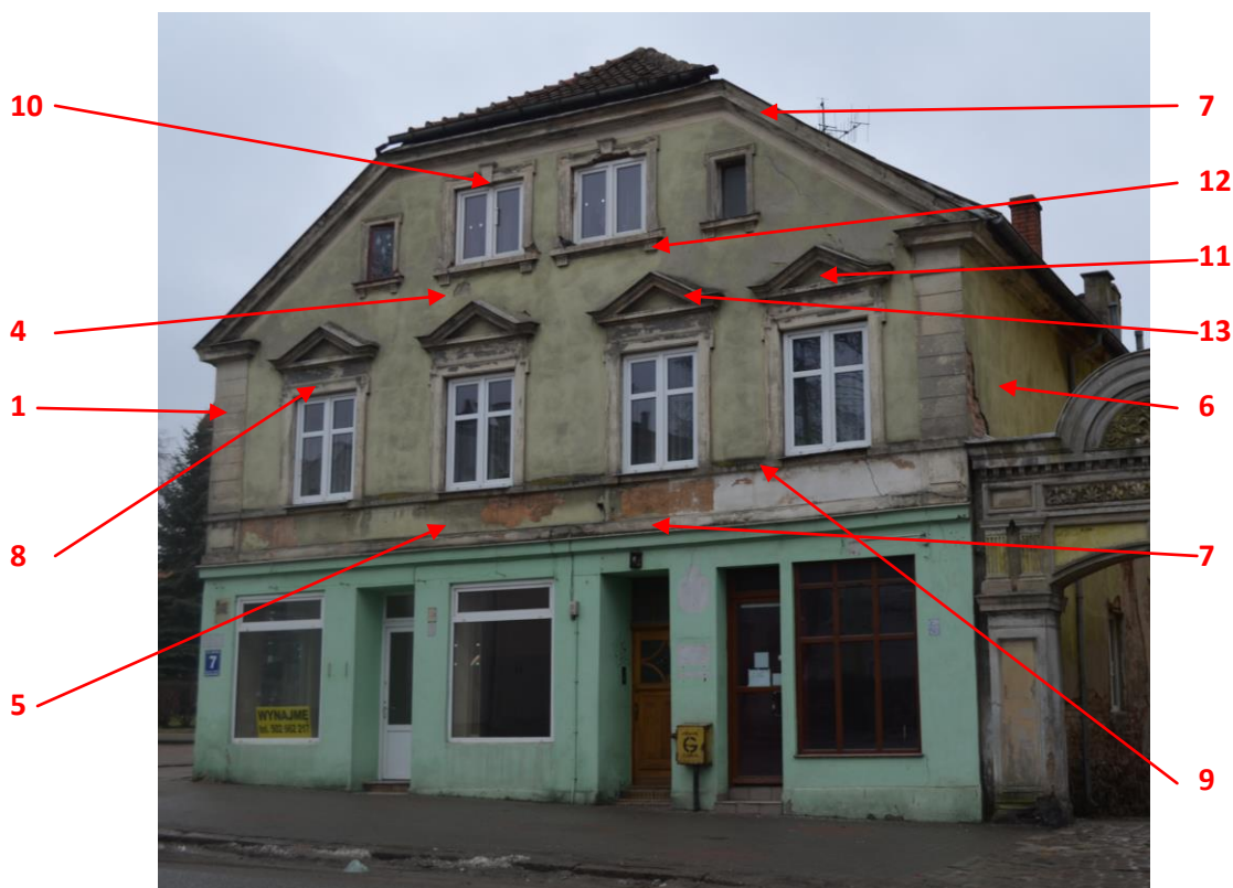
Fot.1. Bartoszyce- budynek mieszkalny przy ul. Bema 7- elewacja frontowa- miejsca pobrania próbek. Fot. M. Feiertag-Baran.
