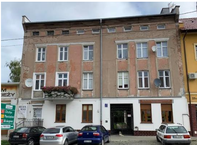
Fot.1. Bartoszyce, budynek mieszkalny ul. Kętrzyńska 25 – elewacja frontowa, stan obecny. Fot. J.Baran.
