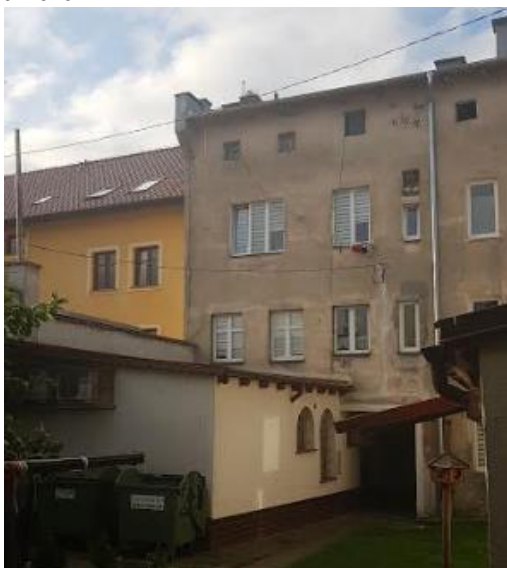
Fot.3. Bartoszyce, budynek mieszkalny ul. Kętrzyńska 25 – elewacja tylna, stan obecny. Fot. J.Baran.
