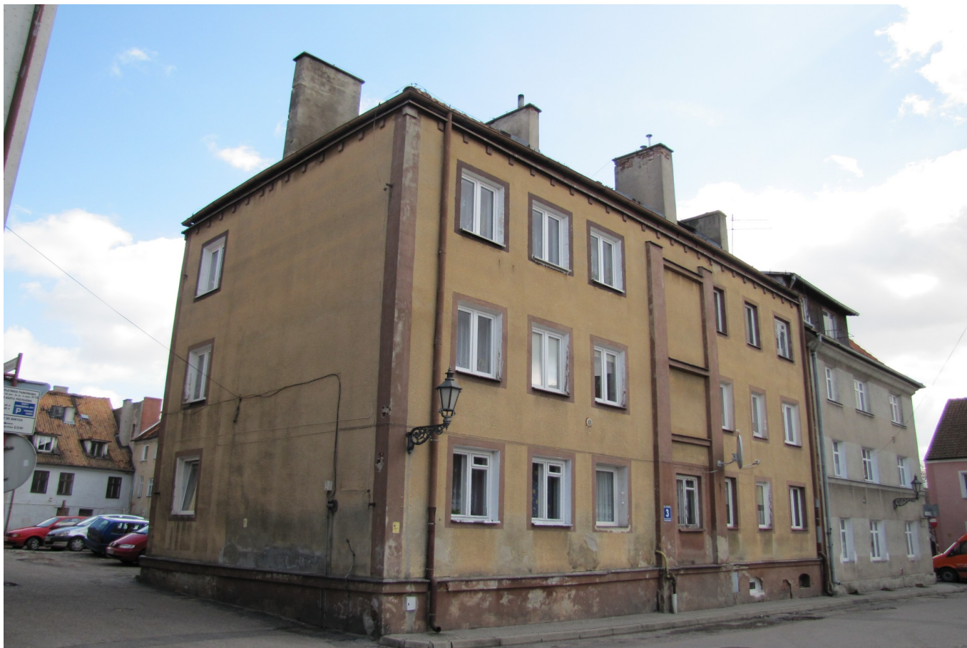
Widok ściany frontowej i szczytowej (z W na E)
