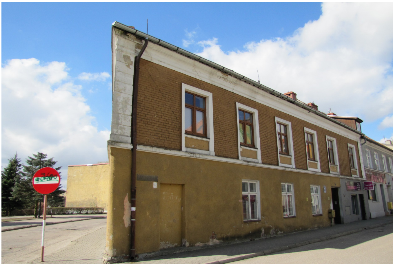
Widok ściany frontowej (z E na W)
