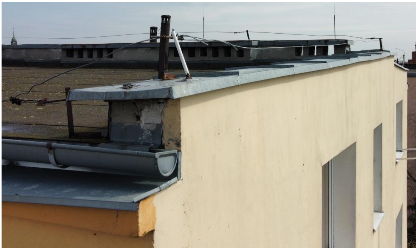
Fot. 4. Widok attyki.
