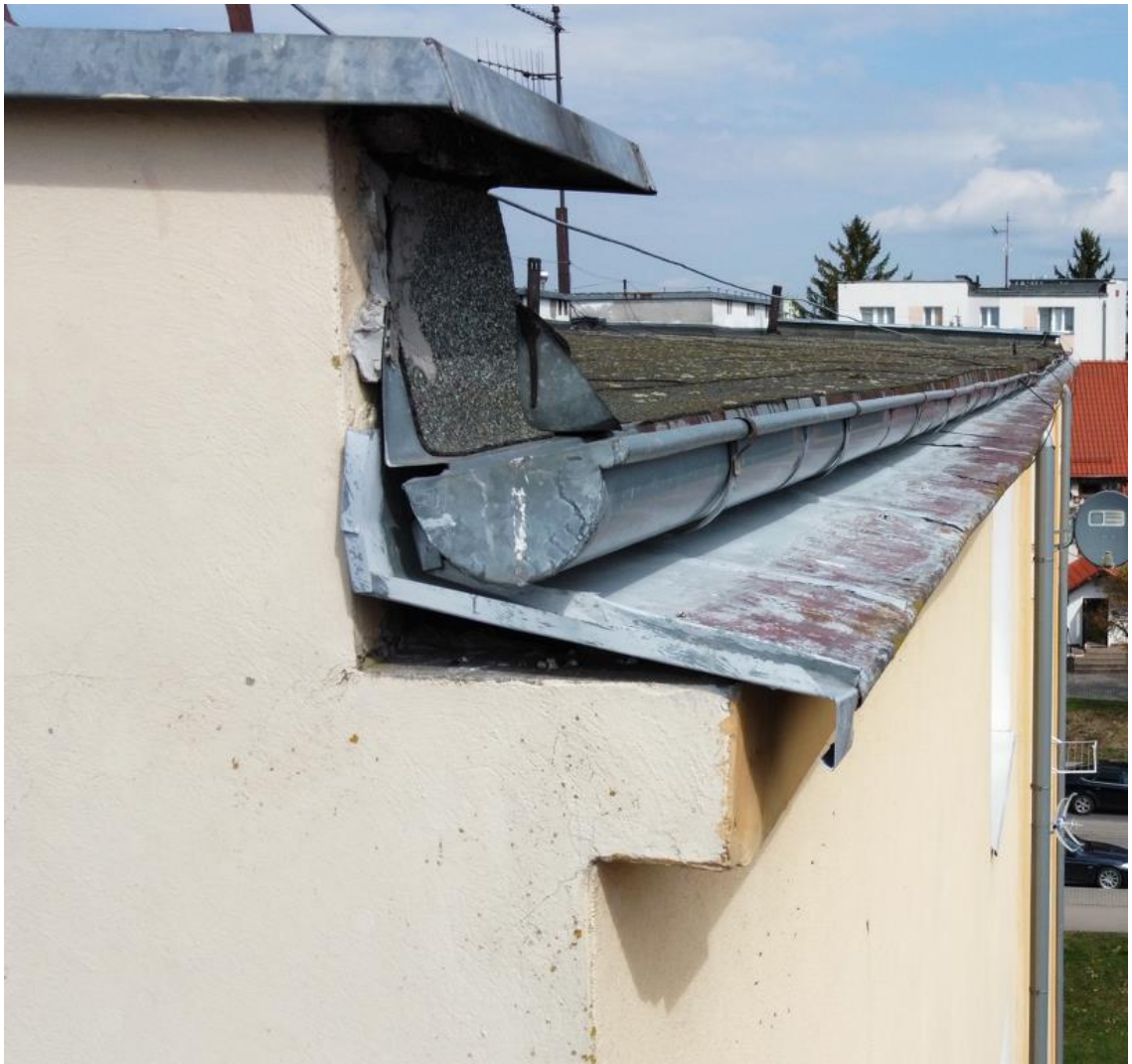
Fot. 3. Widok obróbek blacharskich wraz z oryynnowaniem.
