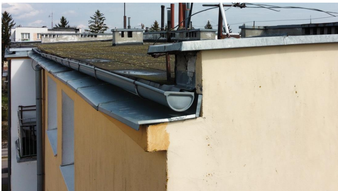
Fot. 1. Widok obróbek blacharskich wraz z orywnowaniem.
