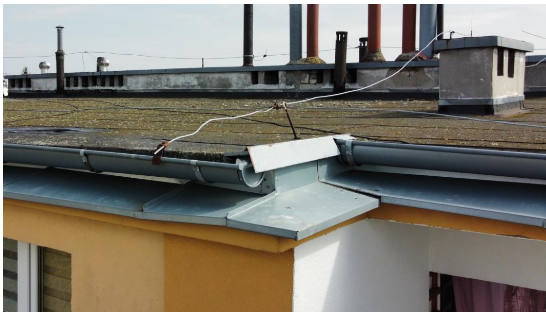
Fot. 2. Widok obróbek blacharskich wraz z orywnowaniem.
