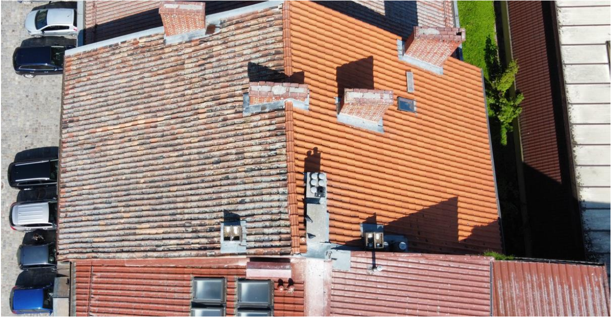
Fot. nr 1. Widok połaci dachowej.
