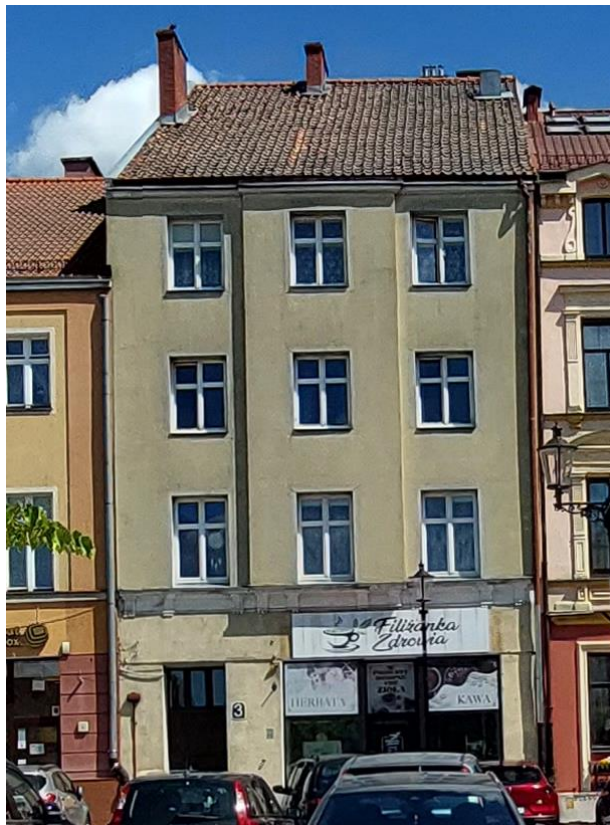
Fot. nr 1. Elewacja południowo- zachodnia.
