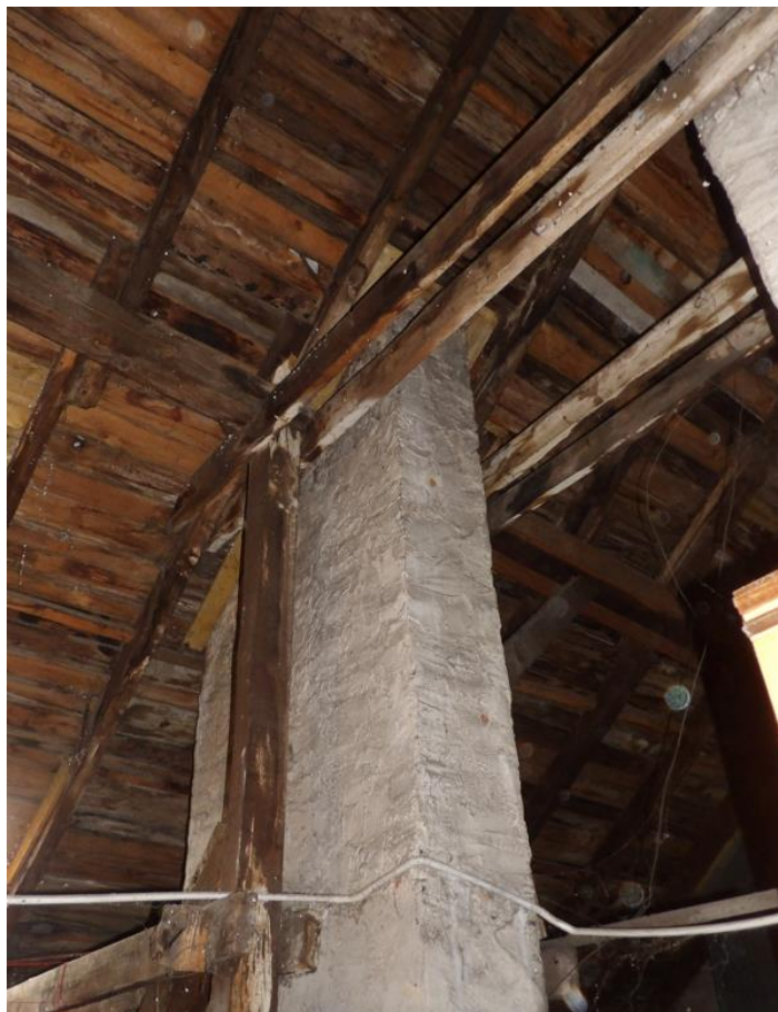
Fot. nr 9. Widok istniejących kleszczy podlegających wymianie.
