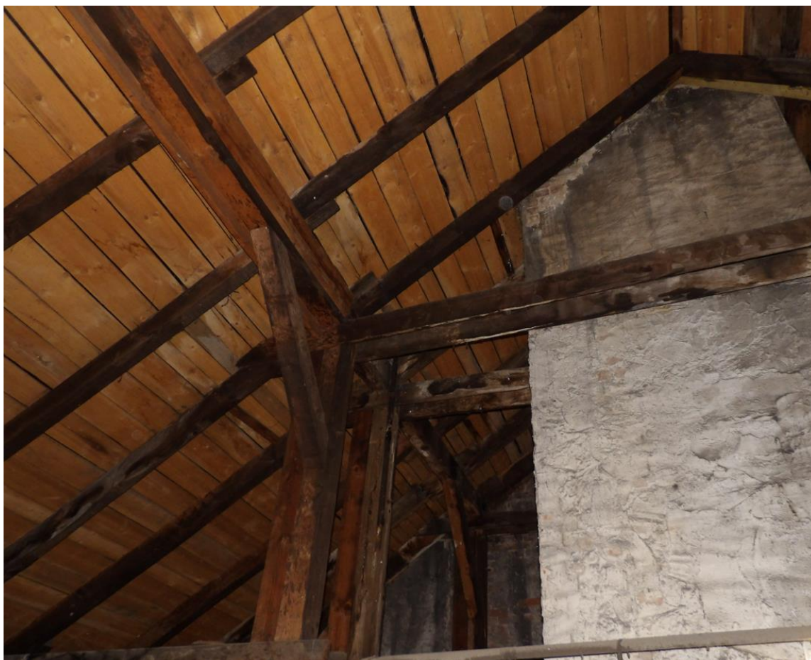
Fot. nr 6. Widok istniejącej konstrukcji więźby przeznaczonej do oczyszczenia i zaimpregnowania; deskowanie do demontażu.
