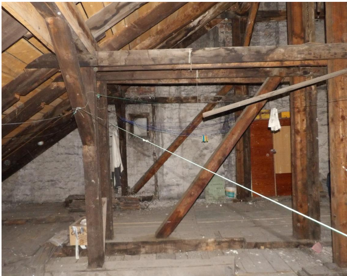
Fot. nr 7. Widok istniejącej konstrukcji wieży przeznaczonej do oczyszczenia i zaimpregnowania.
