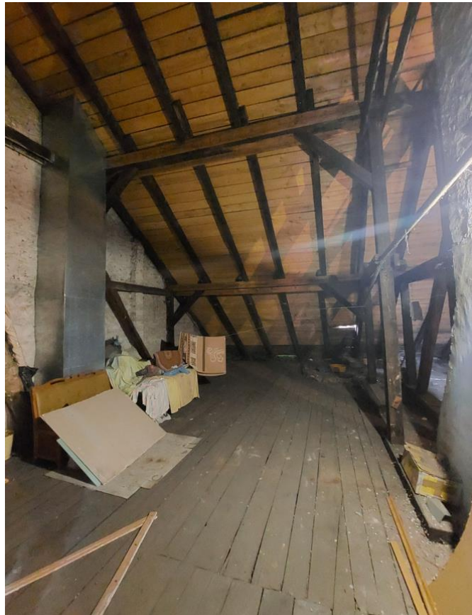
Fot. 4. Konstrukcja więźby na nowy deskowanie.
