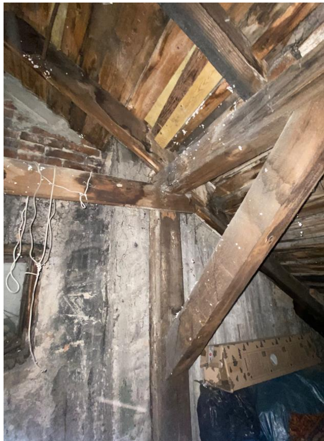
Fot. 5. Konstrukcja więźby podlegająca oczyszczeniu.
