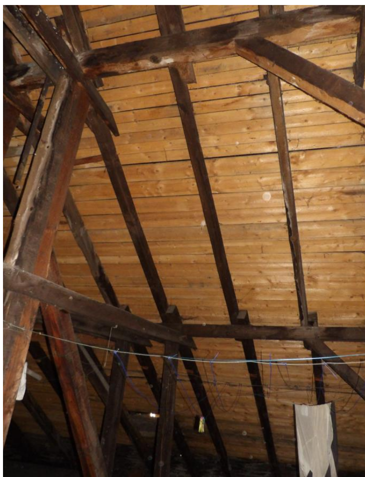
Fot. 3. Konstrukcja więźby na nowym deskowaniu.
