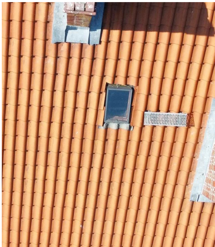
Fot. 9. Istniejący wyłaza wraz ze stopniem kominiarskim przeznaczony do demontażu.
