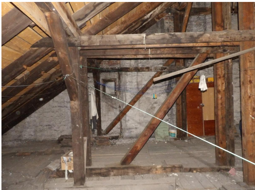
Fot. 1. Widok konstrukcji więźby wraz z deskowaniem.
