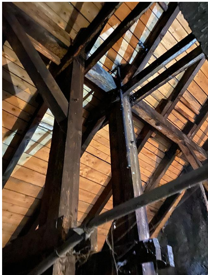
Fot. 2. Widok konstrukcji więźby podlegającej oczyszczeniu i zaimpregnowaniu.
