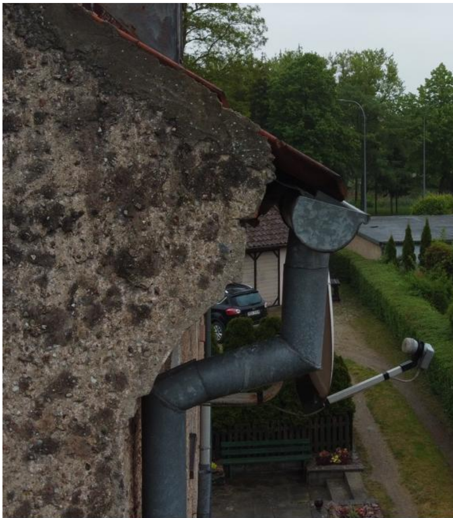
Fot. nr 11. Widok orynnowania i rur spustowych.
