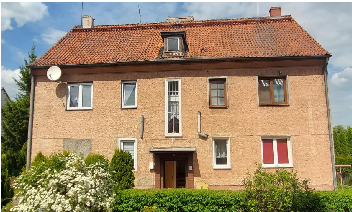
Fot. nr 2. Elewacja południowa.
