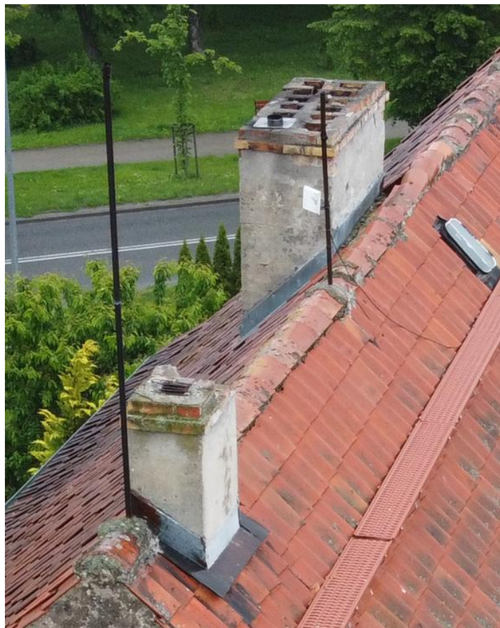
Fot. nr 10. Widok kominów do przemurowania
