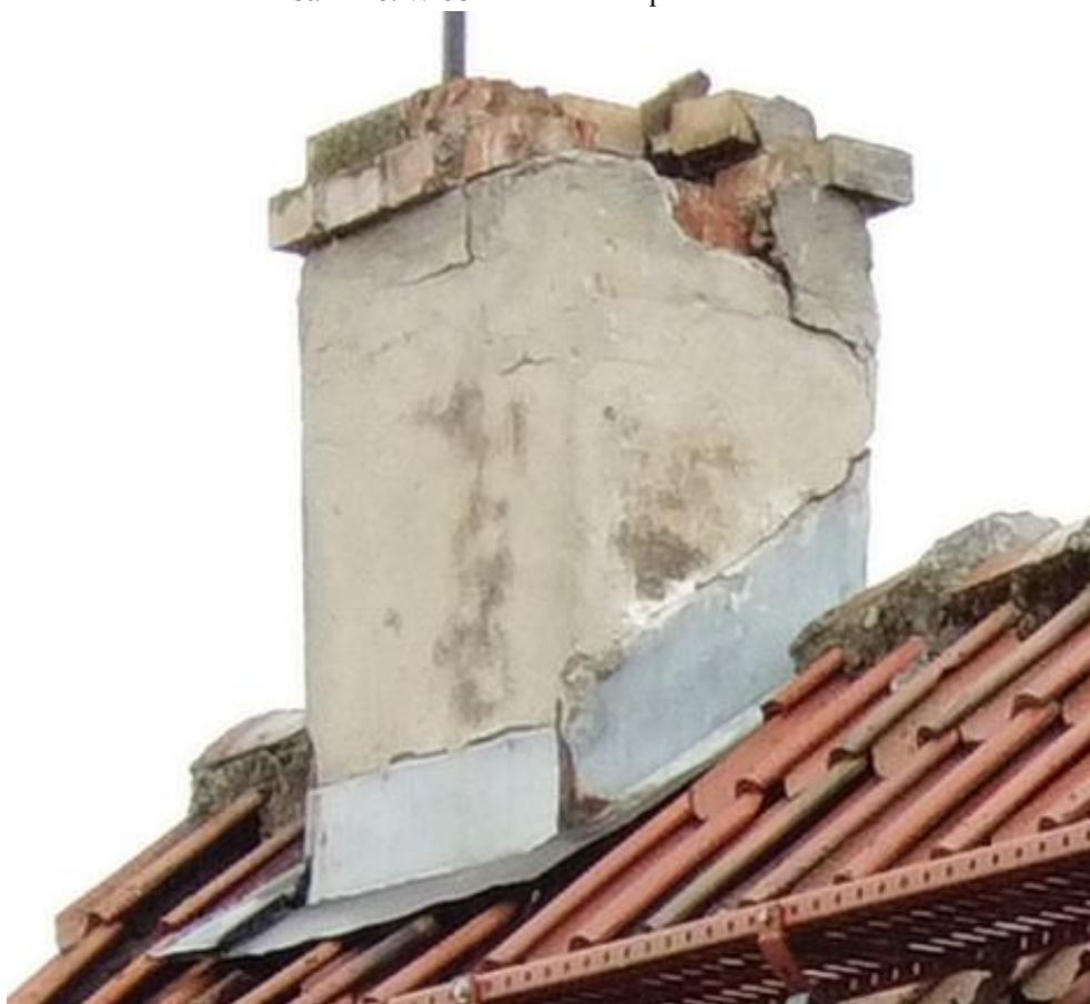
Fot. nr 11. Widok komina do przemurowania.
