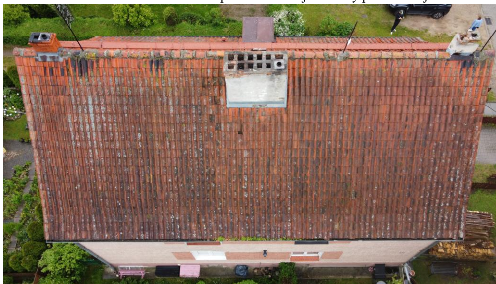
Fot. nr 7. Widok połaci dachowej od strony północnej
