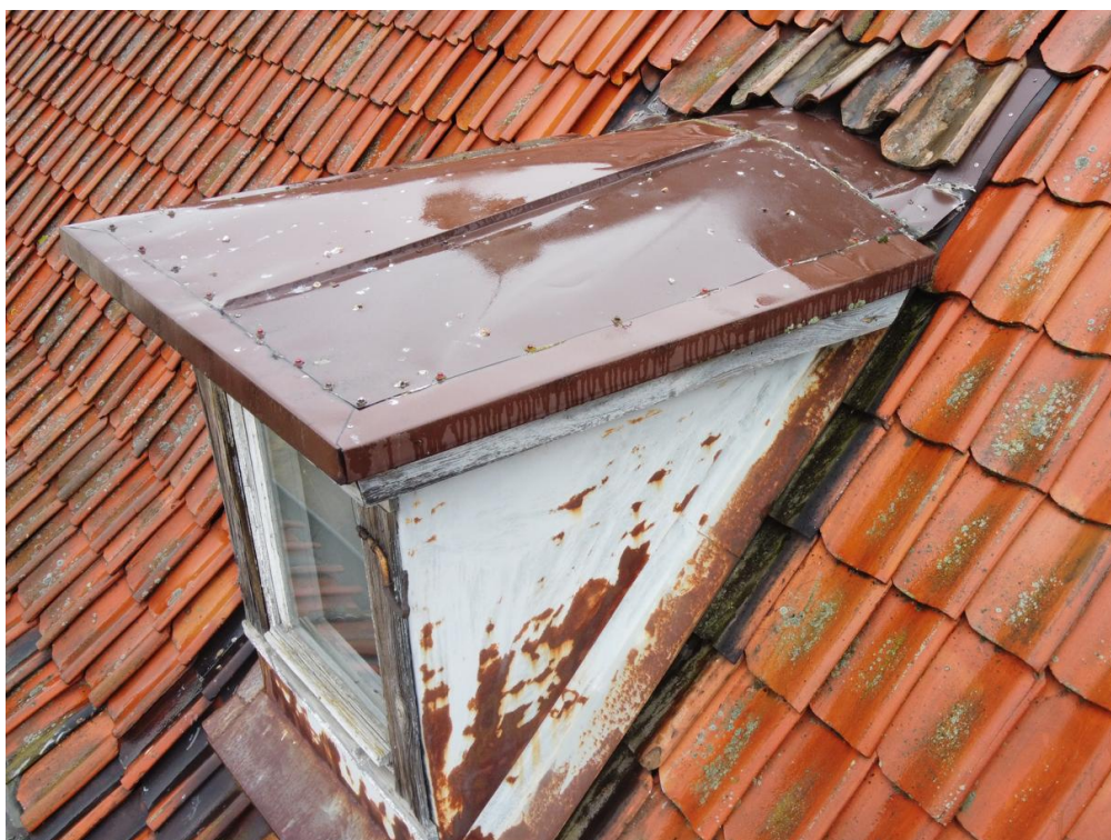
Fot. nr 9. Widok pokrycia lukarny.
