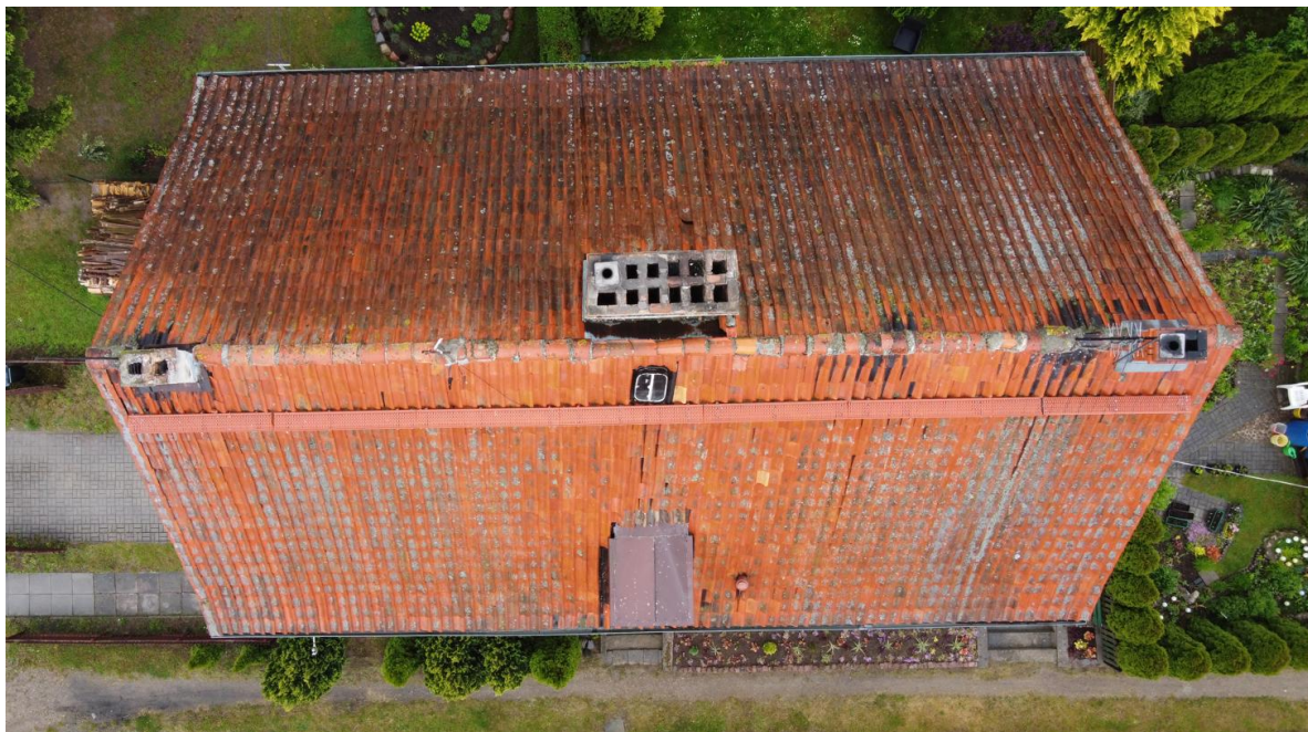
Fot. nr 5. Widok połaci dachowej.
