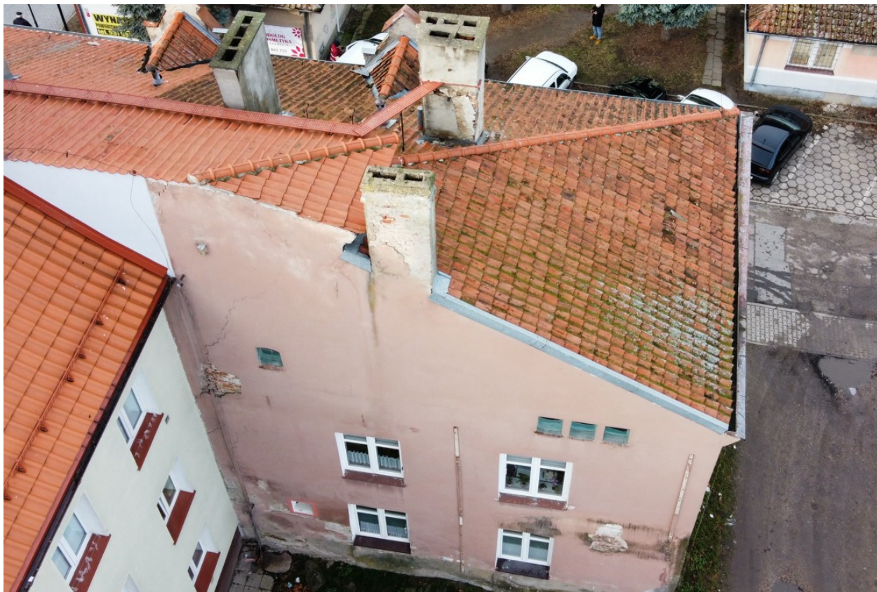
Fot. 6. Istniejące pokrycie dachowe – widok od strony południowo- wschodniej (od podwórza).
