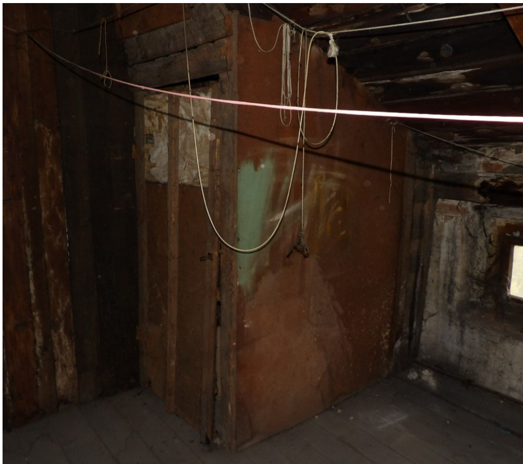
Fot. 2. Widok ścianek działowych z płyt plisniowych przeznaczonych do rozbiórki.
