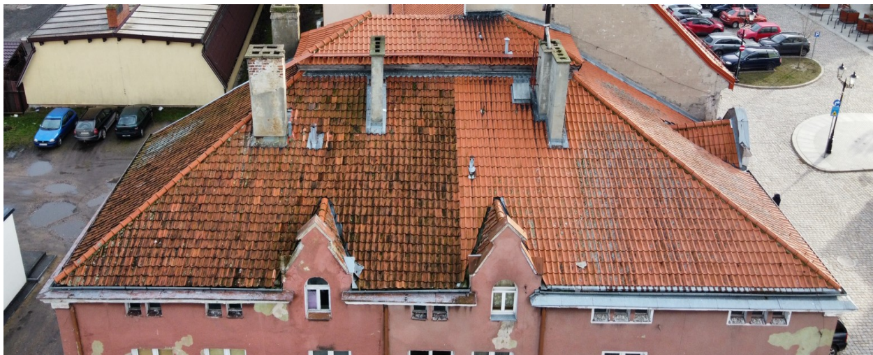
Fot. 5. Istniejące pokrycie dachowe do demonontażu.
