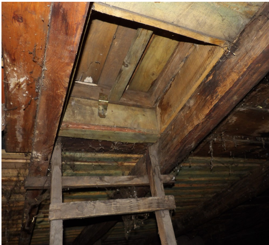
Fot. 11. Istniejący wylaz- widok od środka.
