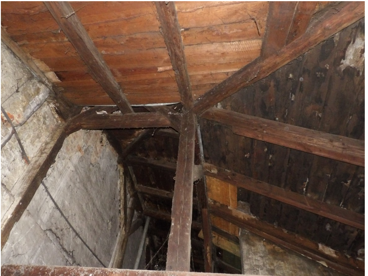
Fot. 4. Konstrukcja wieży.
