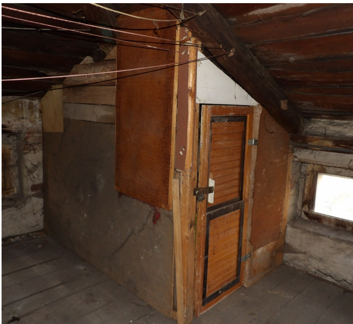
Fot. 1. Widok ścianek działowych z płyt pilśniowych przeznaczonych do rozbiórki
