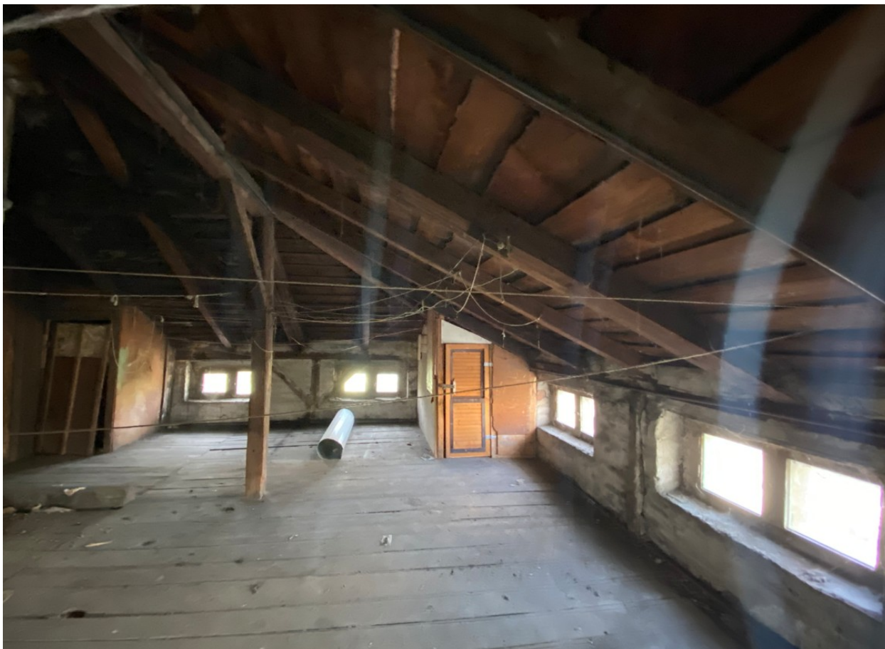
Fot. 9. Widok strychu; deskowania do demontażu.
