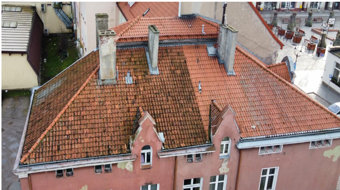
Fot. nr 5. Widok dachu od strony północno- zachodniej.
