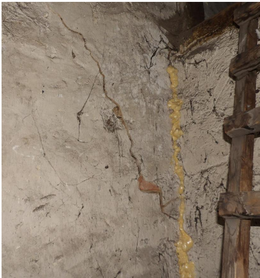
Fot. nr 16. Widok spękania ściany podlegającej naprawie od wewnątrz.
