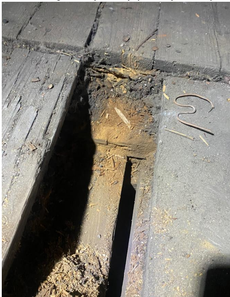
Fot. nr 19. Deskowanie stropu podlegające rozbiórce.
