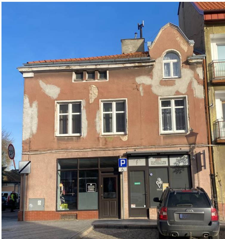
Fot. nr 1. Elewacja południowo- zachodnia.
