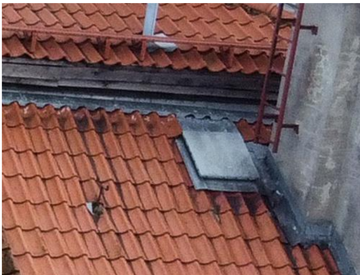
Fot. nr 9. Wyłaz dachowy
