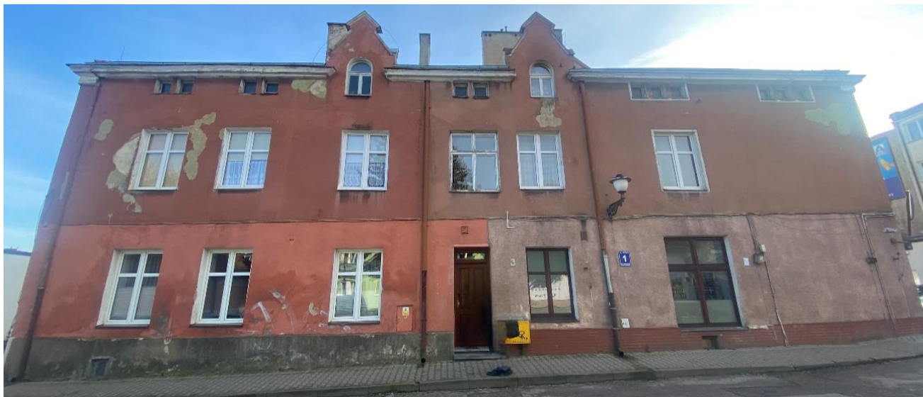
Fot. nr 2. Elewacja północno- zachodnia
