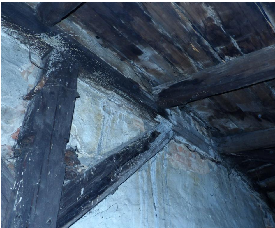
Fot. nr 12. Widok porażonych grzybem końcówek krokwi i deskowania.
