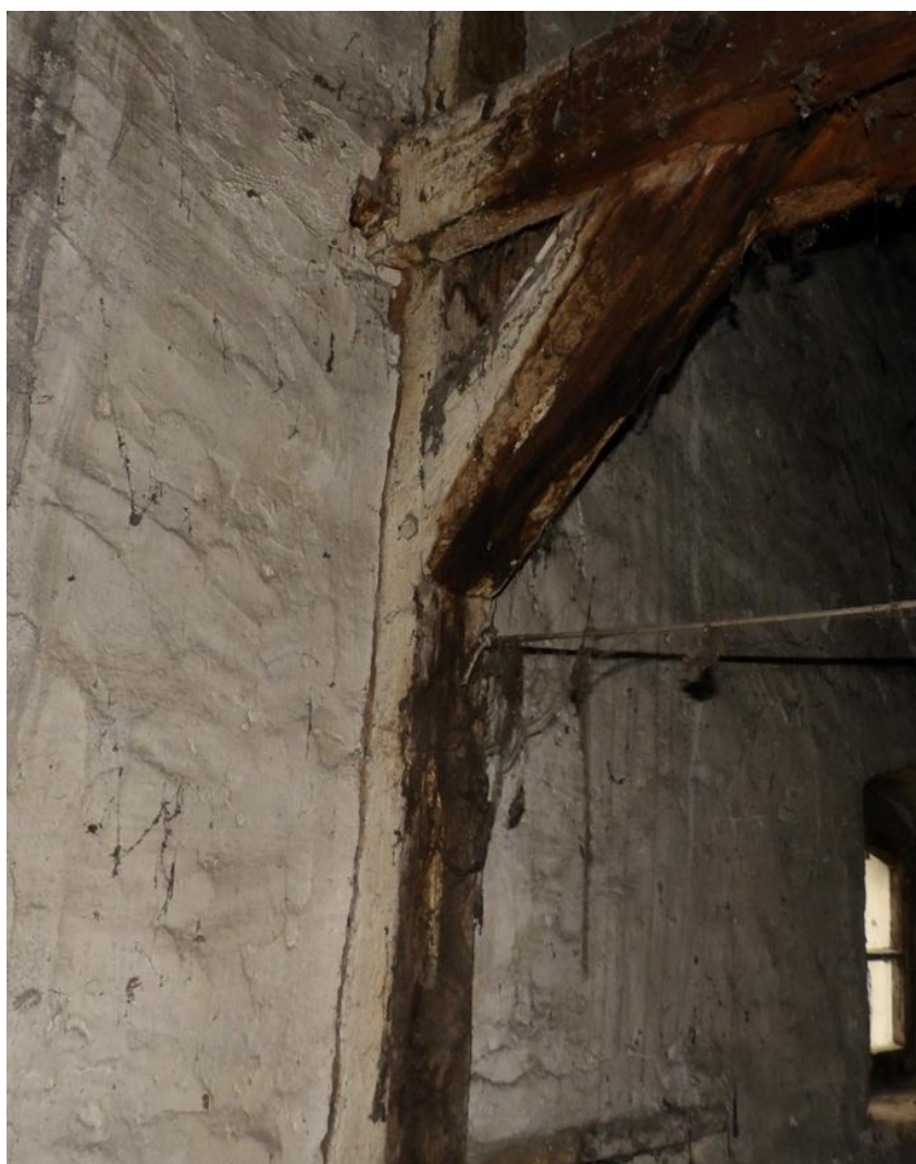
Fot. nr 13. Widok porażonych grzybem słupów i mieczy.
