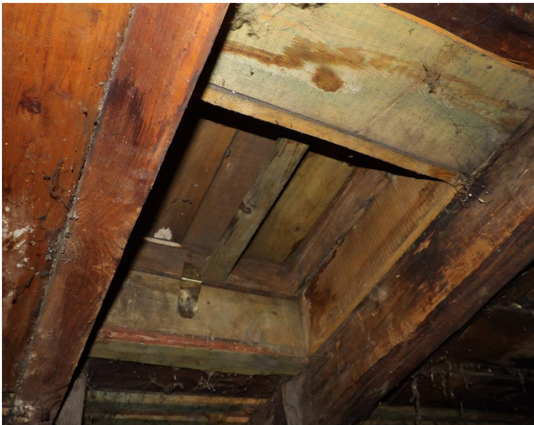
Fot. nr 10. Widok wyłazu od wewnątrz.
