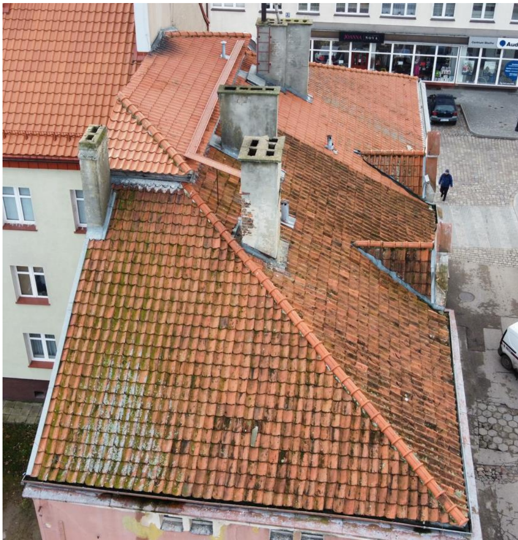
Fot. nr 6. Widok dachu od strony północno- wschodniej.
