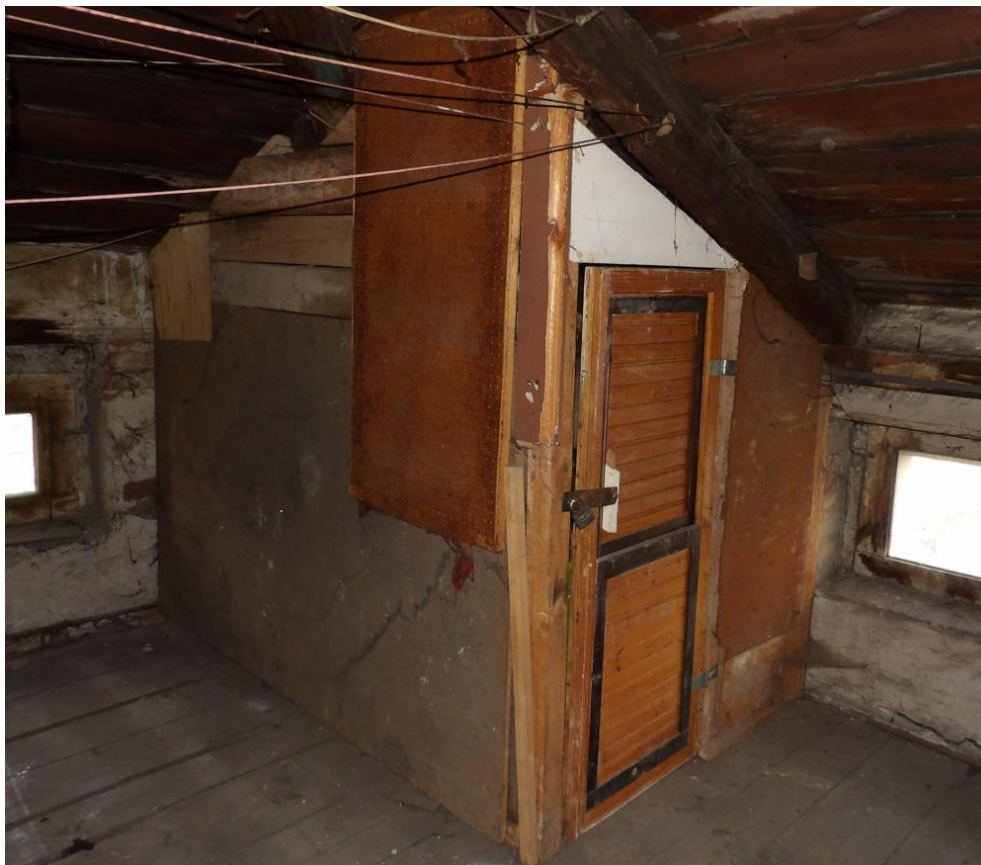
Fot. nr 14. Widok ścianek podlegających rozbiórce.
