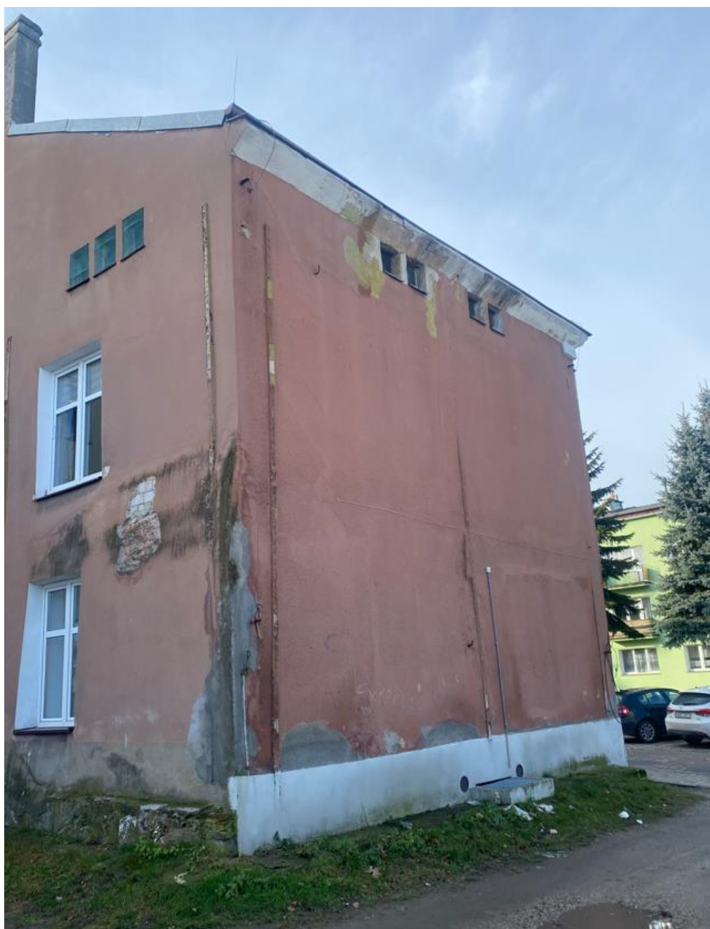
Fot. nr 3. Elewacja północno- wschodnia.
