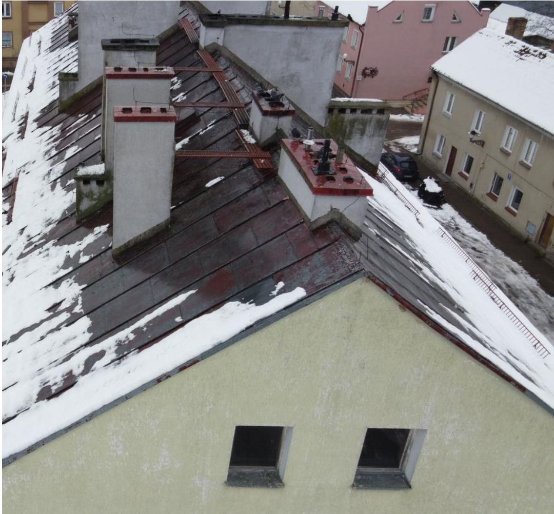
Fot. nr 11. Widok poalci na styku ze ścianą szczytową.
