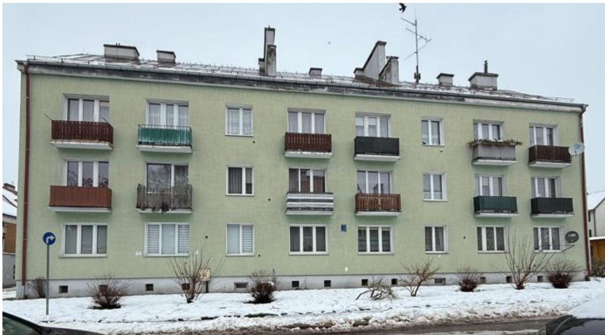
Fot. nr 2. Elewacja południowo- wschodnia.
