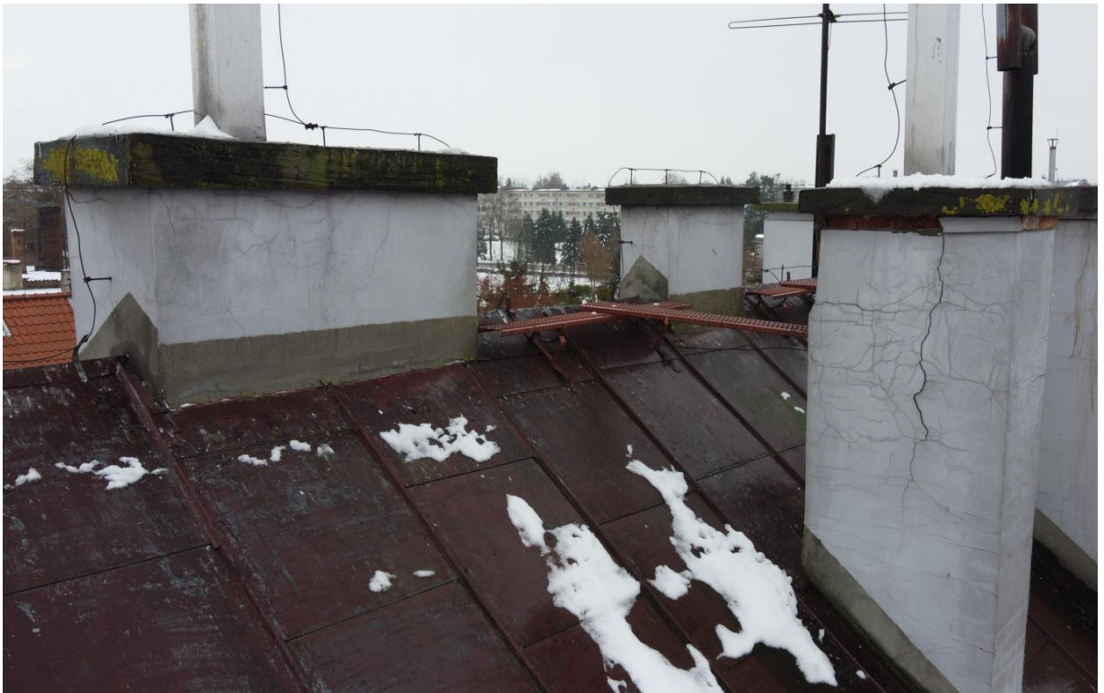
Fot. nr 8. Widok pokrycia połaci dachowej wraz z kominami.
