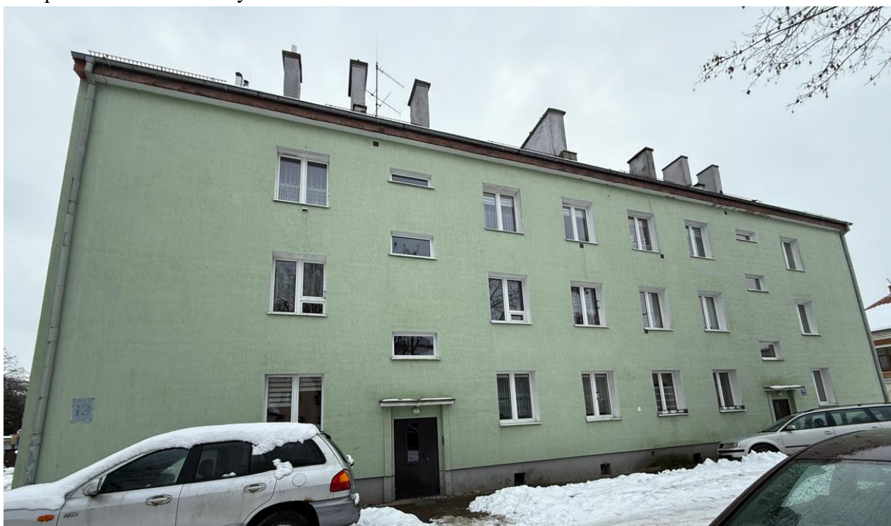
Fot. nr 1. Elewacja północno- zachodnia.
