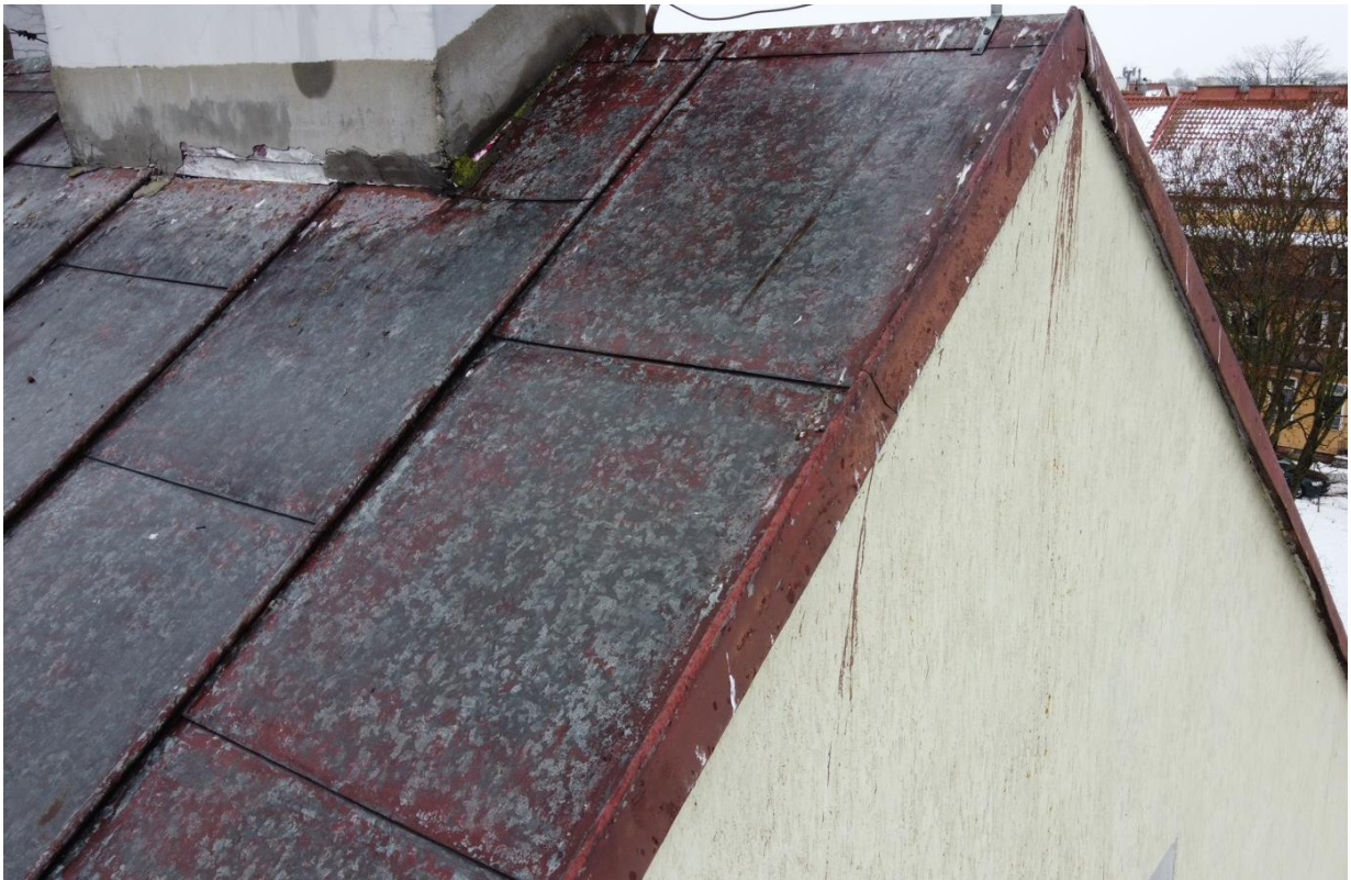
Fot. nr 7. Widok szczegółu pokrycia połaci dachowej.
