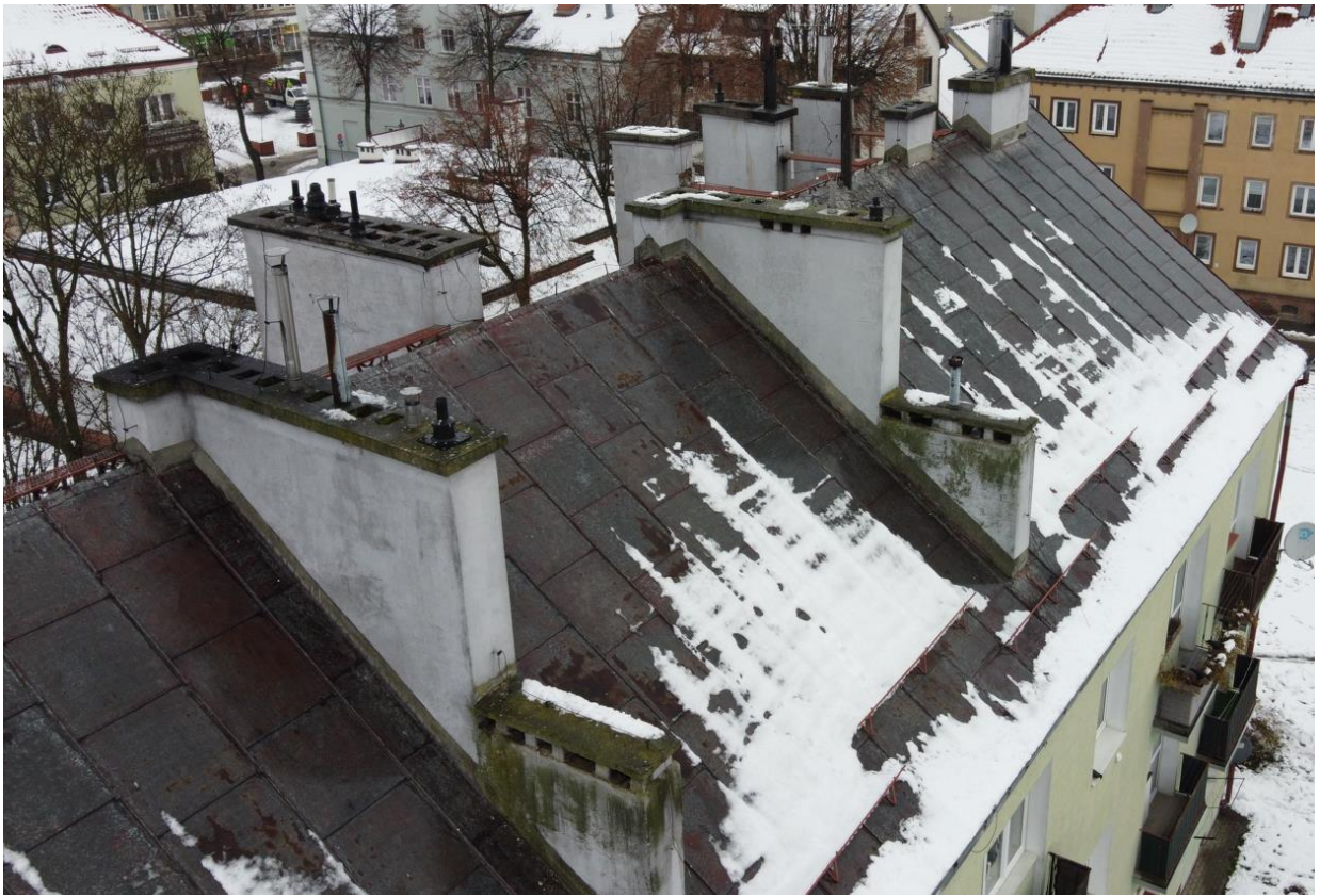
Fot. nr 6. Widok połaci dachowej od strony południowo- wschodniej.
