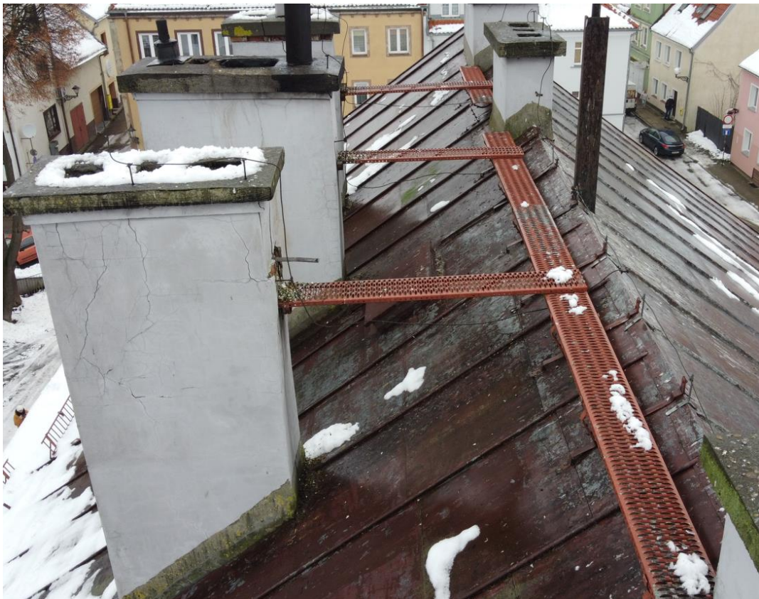
Fot. nr 12. Widok pokrycia wraz ze stopniami kominiarskimi.
