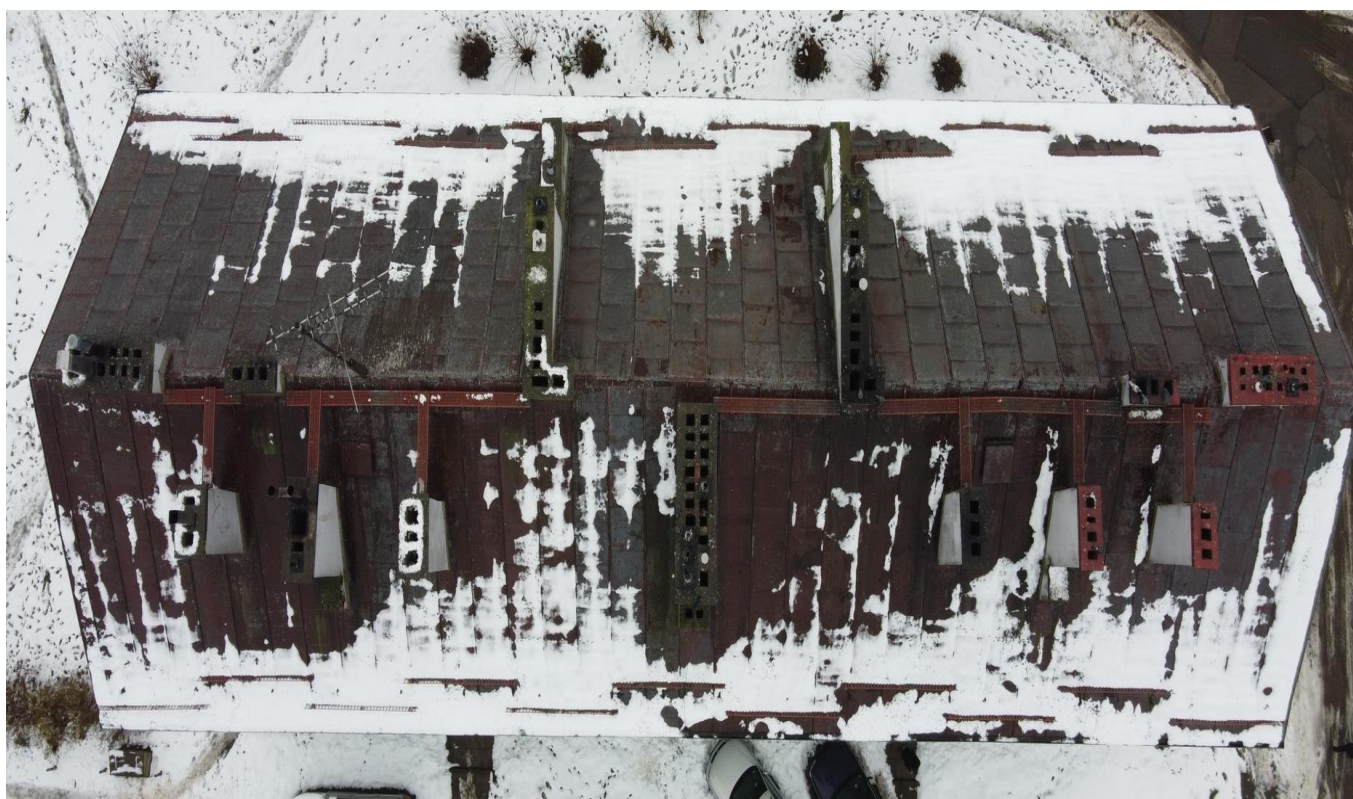
Fot. nr 5. Widok połączeni dachowej.
