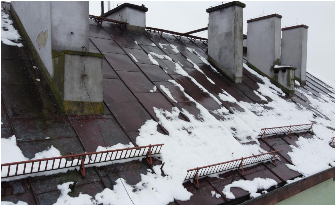
Fot. nr 7. Widok pokrycia połaci dachowej wraz z śniegołapami.
