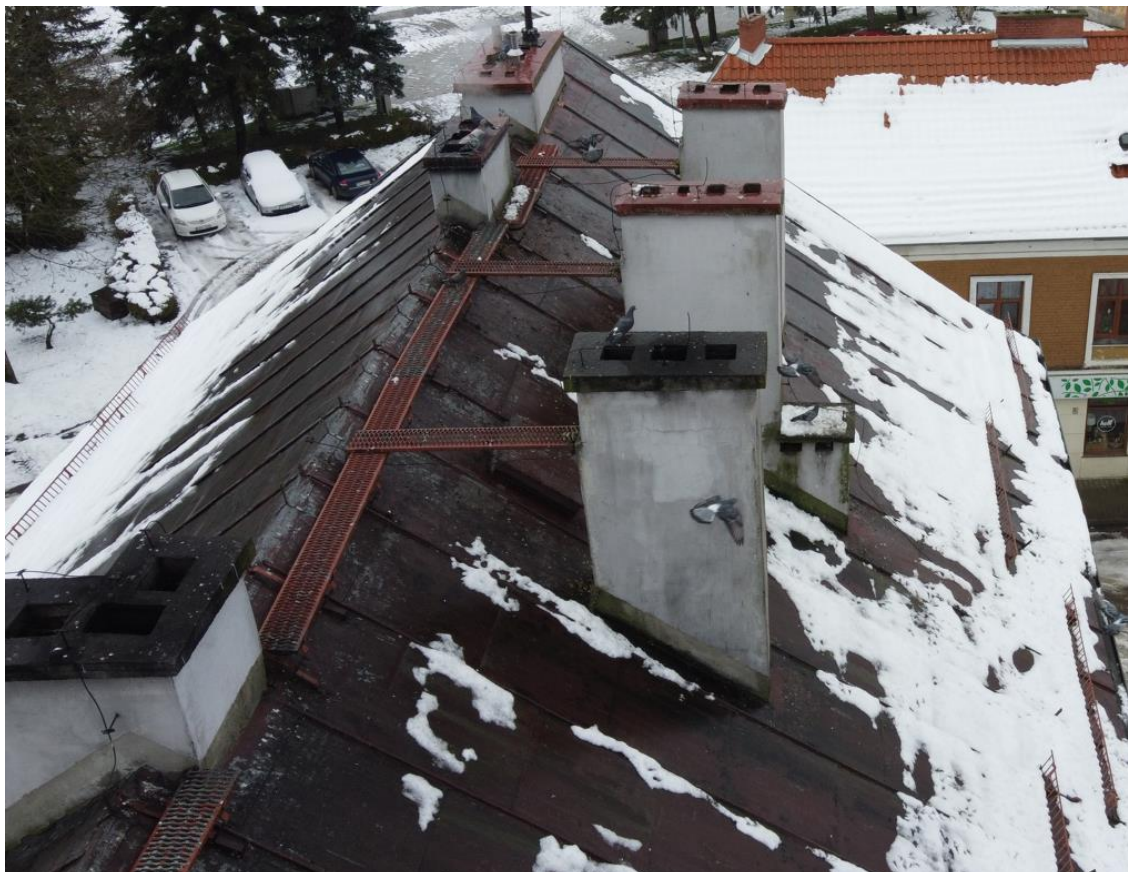
Fot. nr 10. Widok stopni kominiarskich do demontażu.
