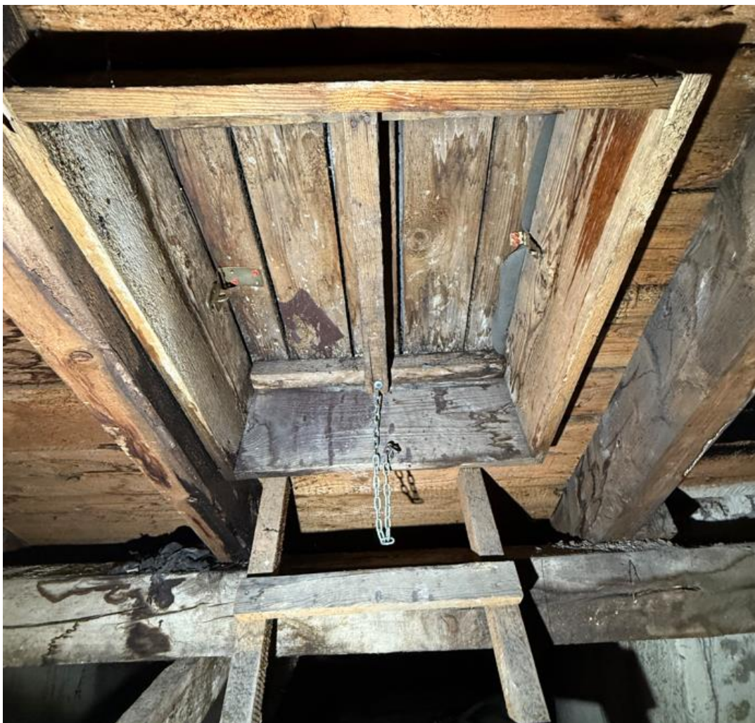
Fot. nr 16. Widok wylazu dachowego od wewnątrz.
