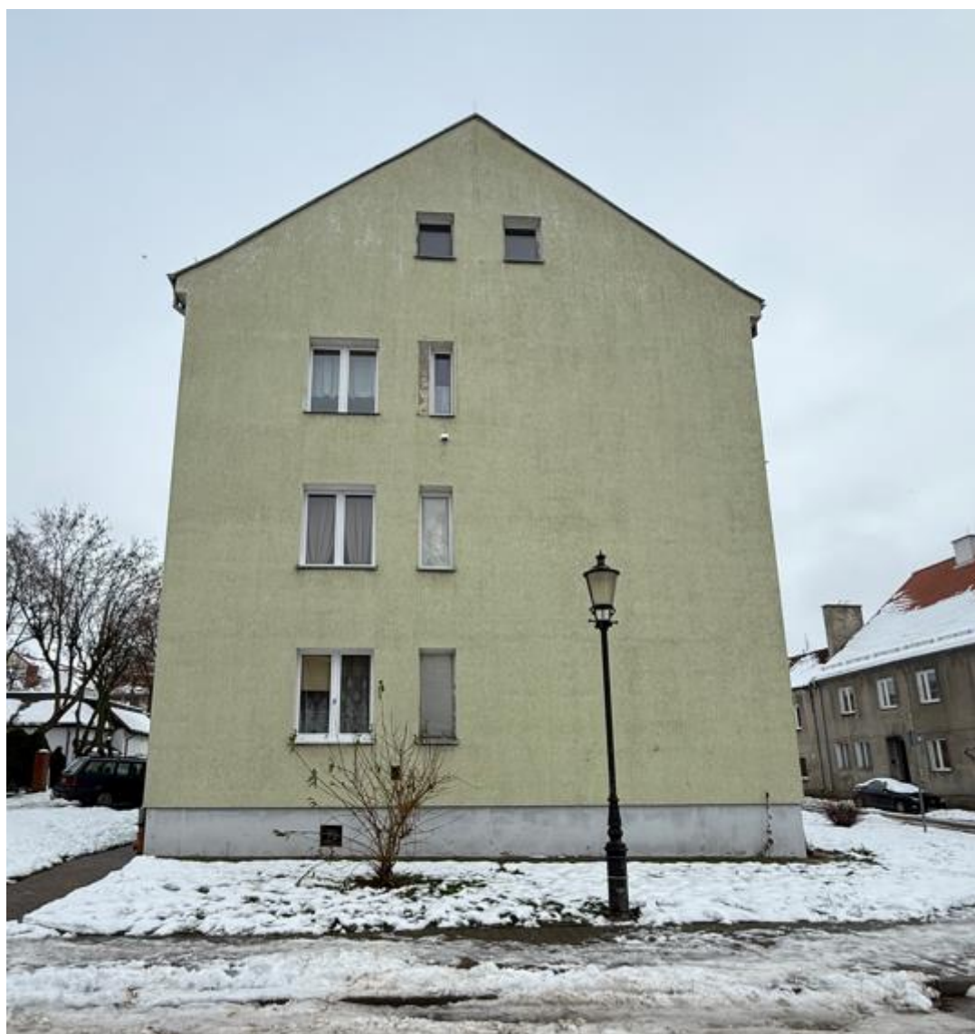
Fot. nr 3. Elewacja południowo- zachodnia.
