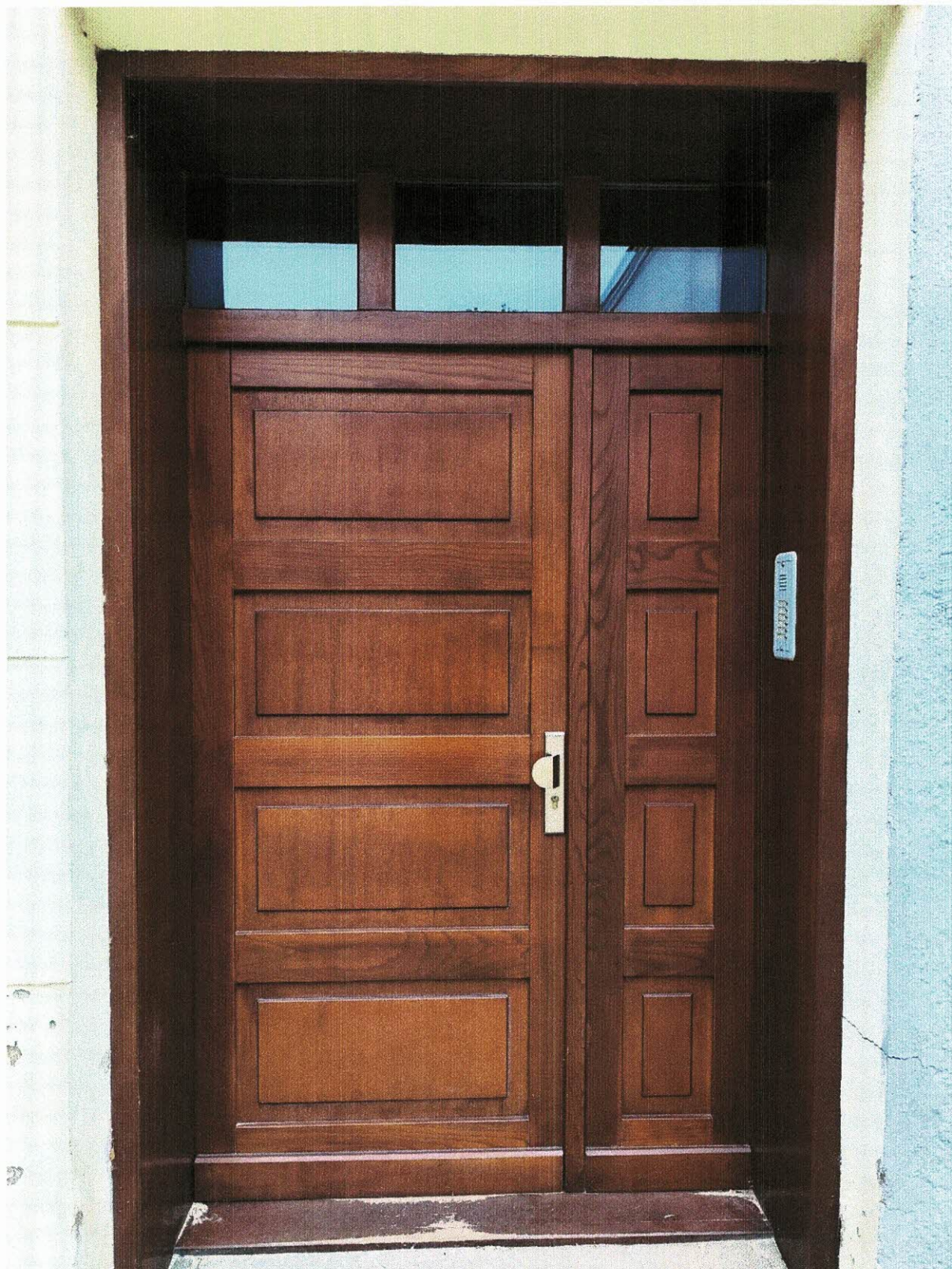
DRZWI WEJŚCIOWE DO BUDYNKU
